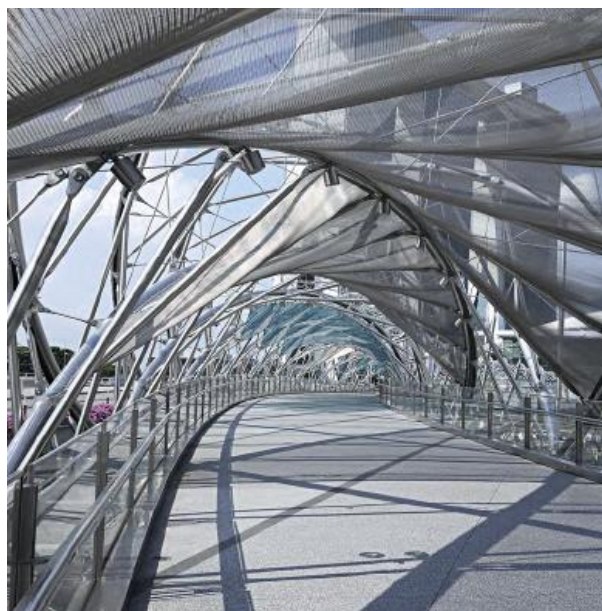
Obr. 18 Helix Bridge, Singapur, vyroben z duplexní oceli 2205 [7].
