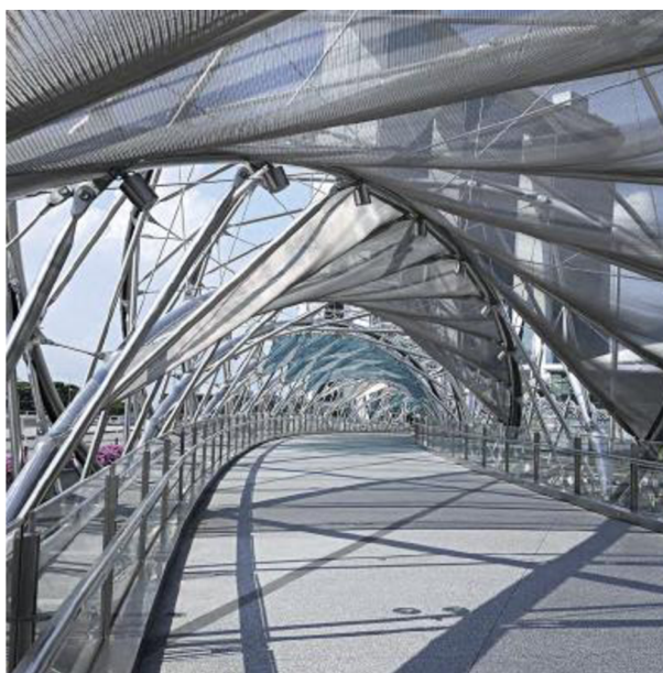
Obr. 18 Helix Bridge, Singapur, vyroben z duplexní oceli 2205 [7].
