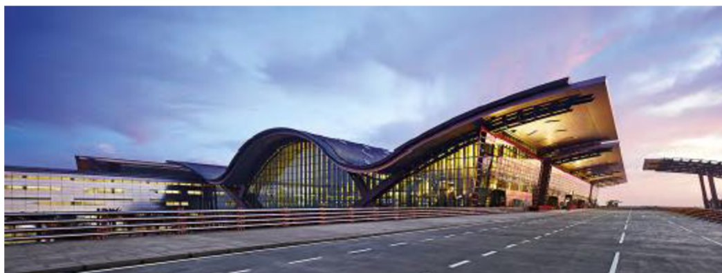
Obr. 3 Mezinárodní letiště Hamad v Dauhá se střechou z duplexní oceli [7].
