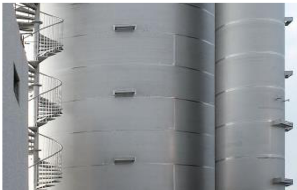
Obr. 17 Skladovací nádrž z oceli 2205 [7].
