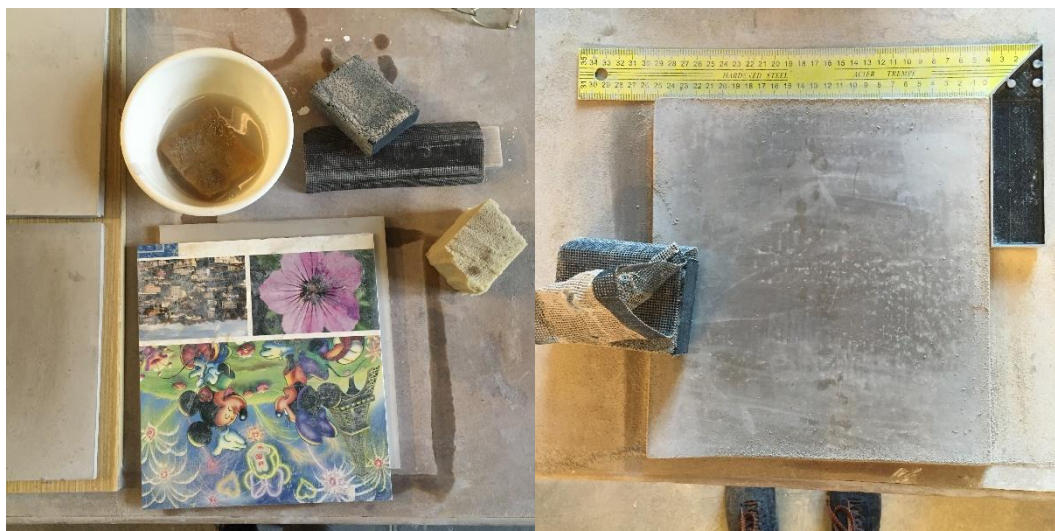
Obrázek 9 – Retušování dlaždic mokrou houbičku a brusnými houbami a hladítkem
