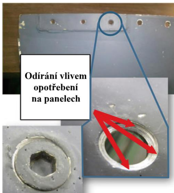
Obrázek 14 - Místo poškození paneláže
