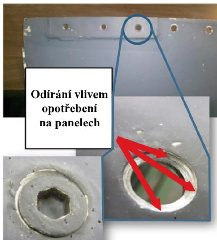
Obrázek 14 - Místo poškození paneláže
