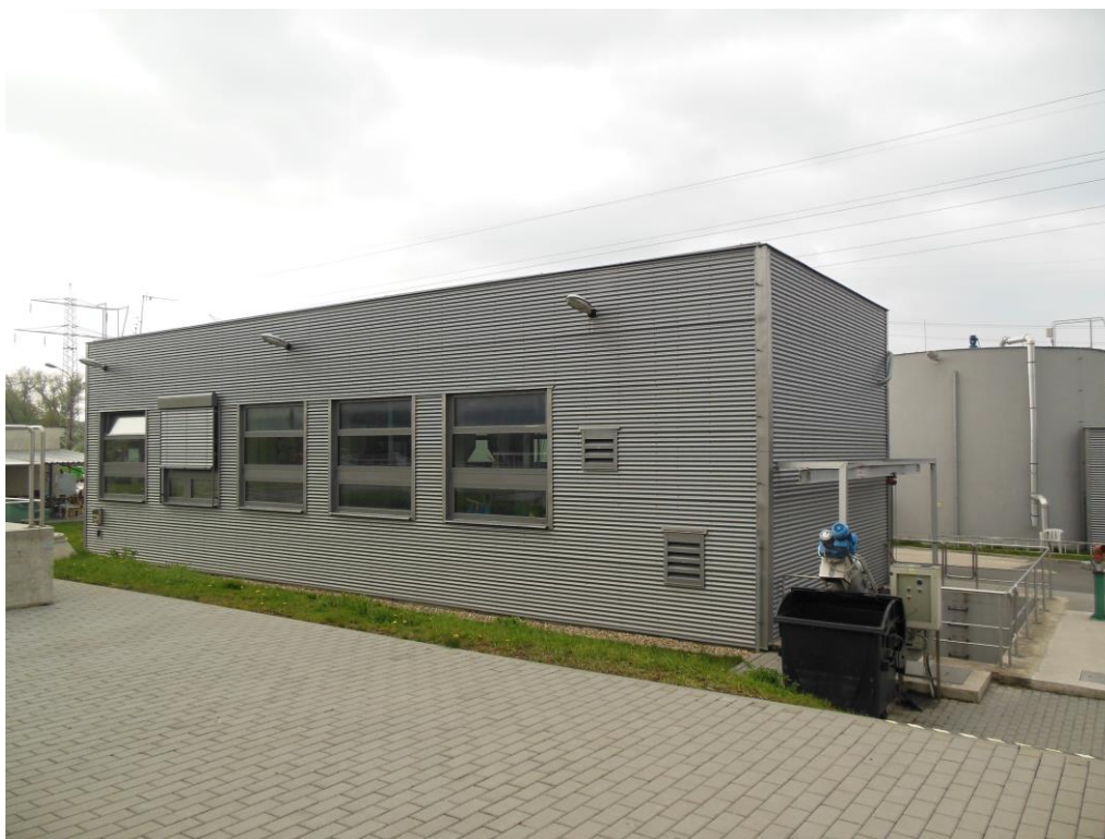
Fotografie č. 3 – Provozní budova (archiv autora)
