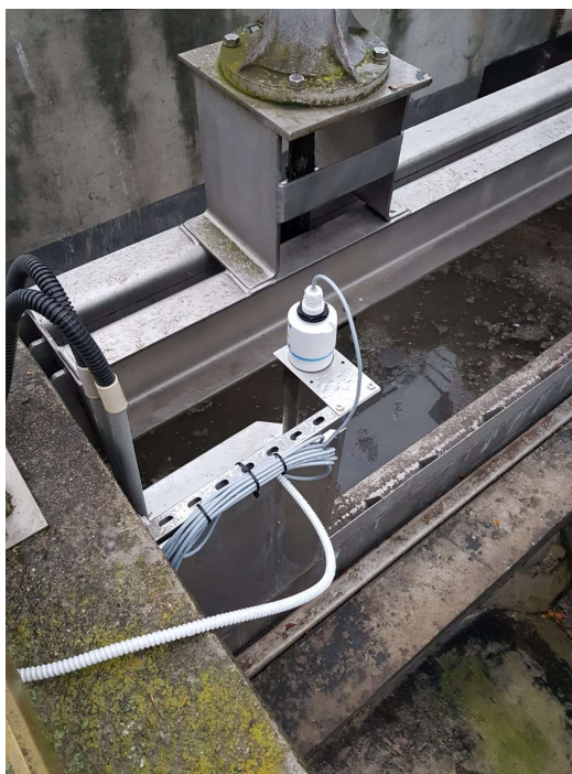
Obr. 33) Detail instalace nového hladinoměrného snímače
