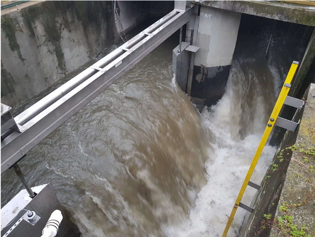
Obr. 35) Přebád vody přes pohyblivý tabulový uzávěr a pevné stavidlo
