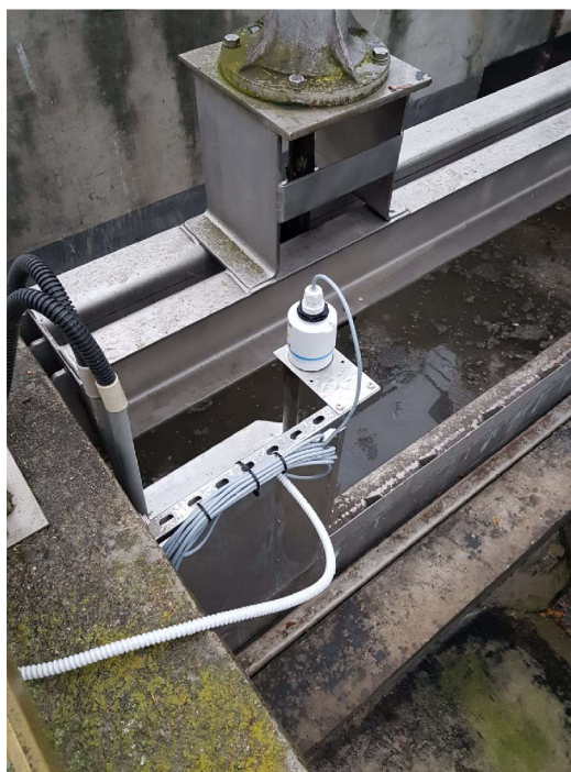
Obr. 33) Detail instalace nového hladinoměrného snímače
