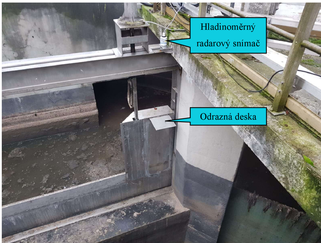
Obr. 34) Pohled na instalaci nového snímače pro měření výškové odlehlosti Z přelivné hrany pohyblivého tabulového uzávěru
