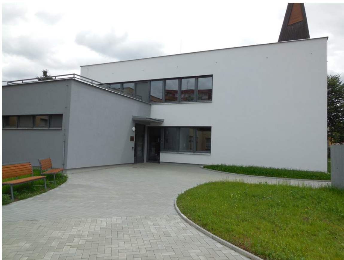
Obr. 5.2: Komunitní centrum po rekonstrukci [27]
