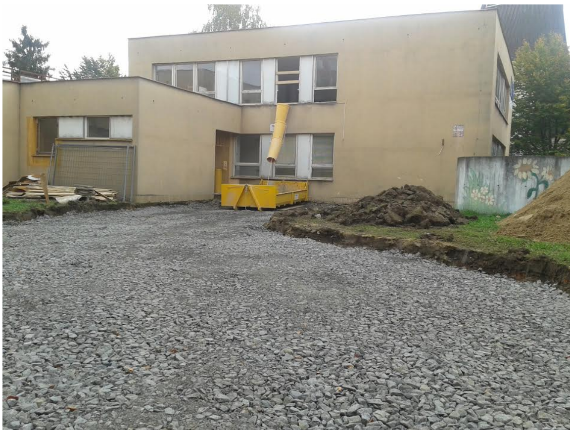
Obr. 5.1: Komunitní centrum před rekonstrukcí [Zdroj: vlastní]
