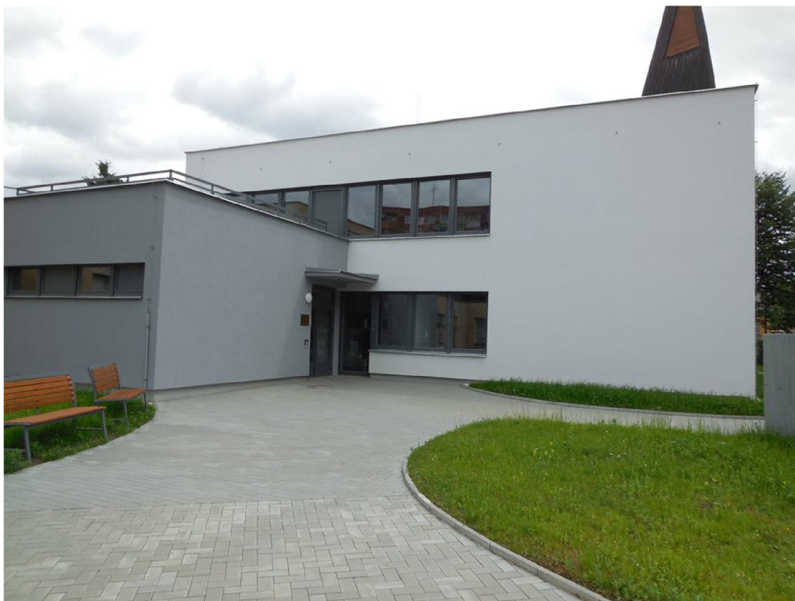
Obr. 5.2: Komunitní centrum po rekonstrukci [27]
