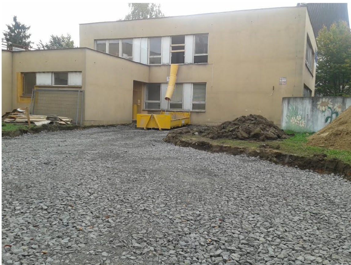
Obr. 5.1: Komunitní centrum před rekonstrukcí [Zdroj: vlastní]
