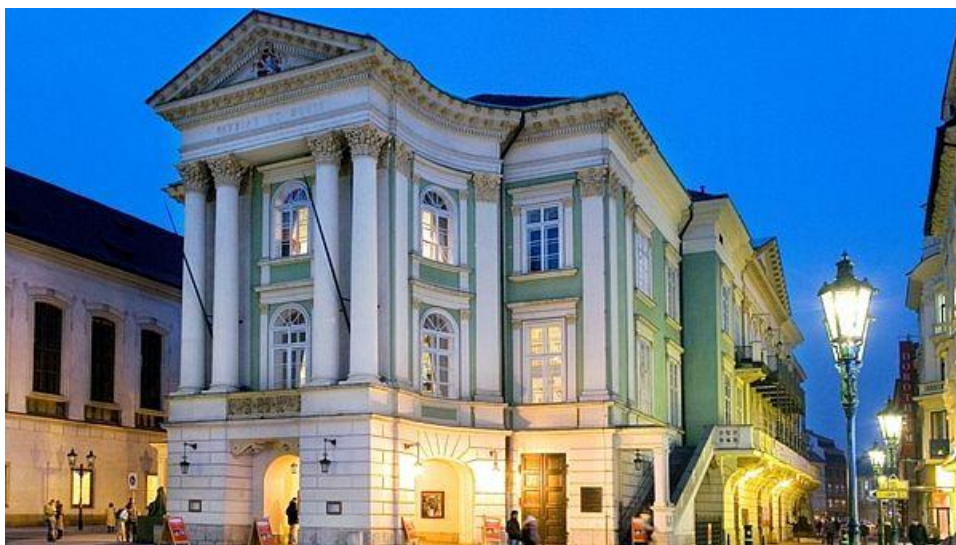
Exteriér Stavovského divadla 79
