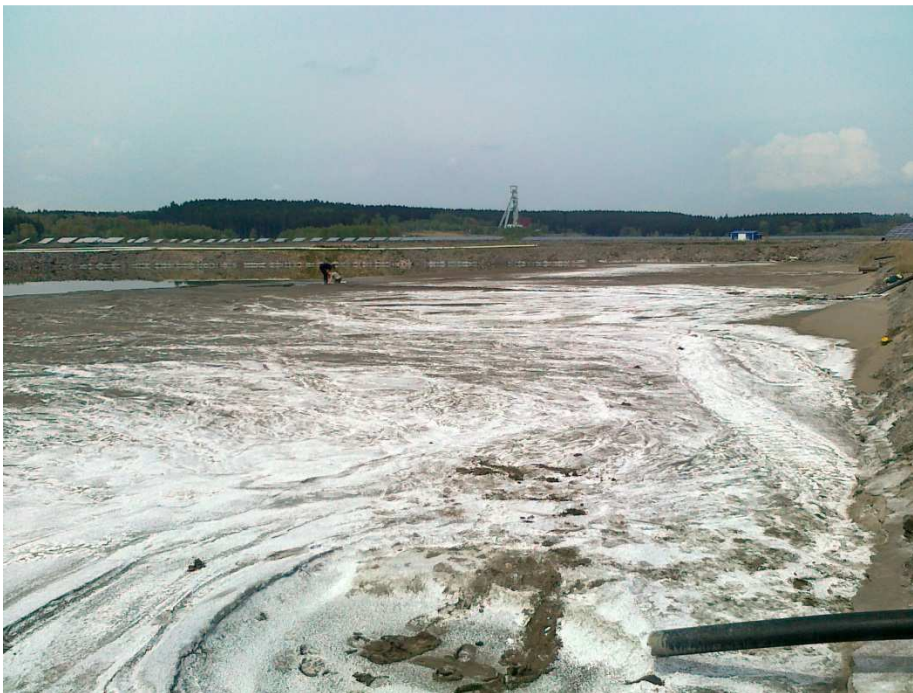
Příloha 23 Krystalizace síranu sodného, odkalovací nádrž KI, Rožná (foto autor)
