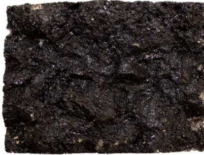
Vrchná časť skúšobného telesa
