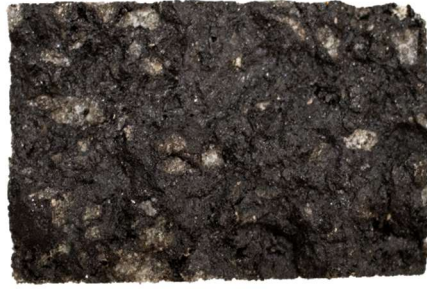
Vrchná časť skúšobného telesa
