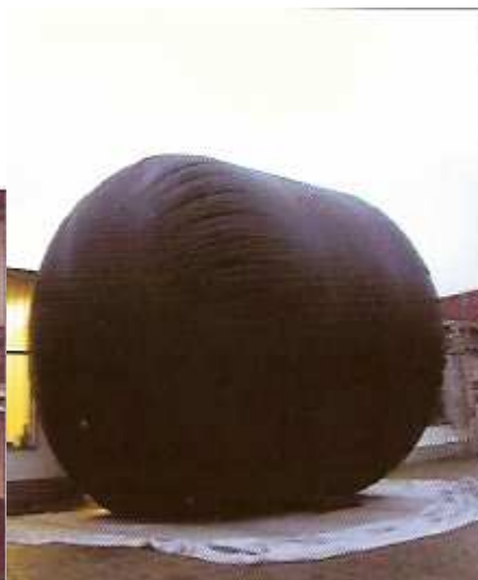
Obr. 3 Plynojem – střecha fermentoru (schéma + realizace) [8]
