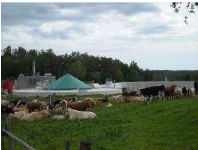
Obr. 17 Fóliový plynojem vnitřního fermentoru [4]
