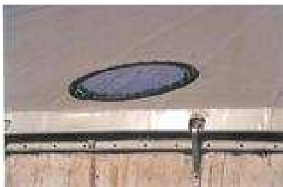
Obr. 21: Průzor pro vizuální kontrolu fermentačního procesu [21]
