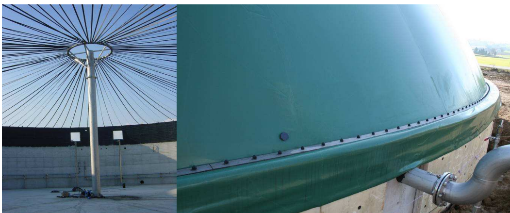
Obr.20 Lana proti klesnutí vnitřní membrány a systém uchycení vnější m. [21]
