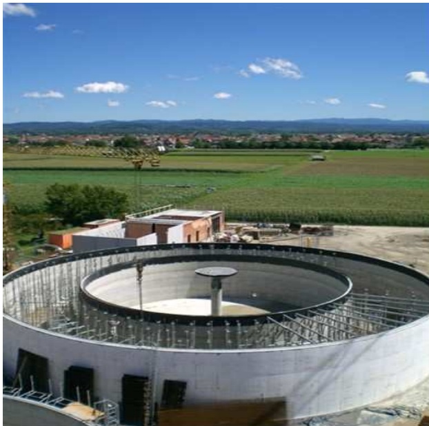
Obr. 16 Stavba fermentoru – systém kruh v kruhu [18]
