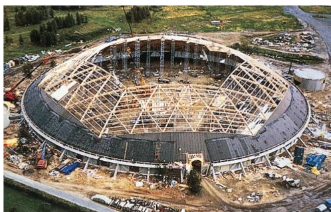
Obrázek 20 Stavba sportovní haly za použití vrstvených nosníků, Oulo, Finsko, (www.puuinfo.ee)
