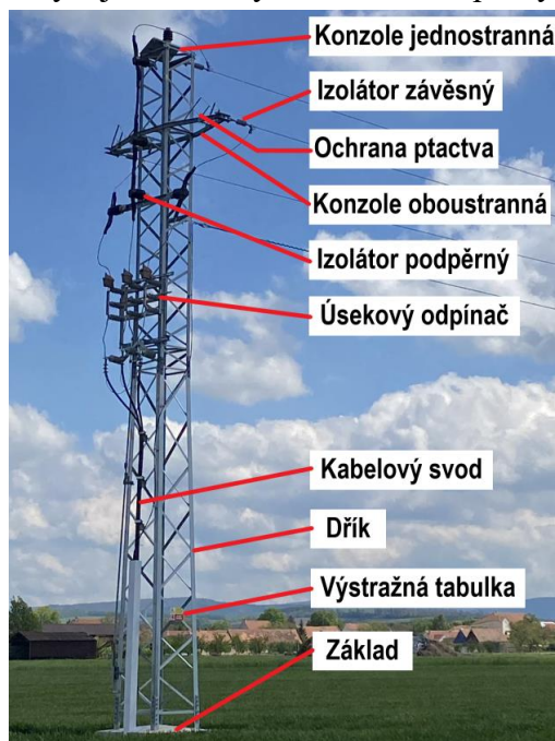
Obrázek 2.1 - Části příhradového stožáru [vlastní zpracování]
