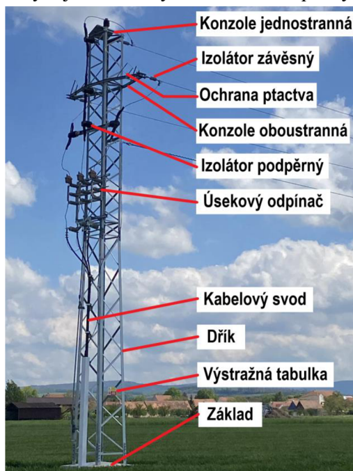
Obrázek 2.1 - Části příhradového stožáru [vlastní zpracování]
