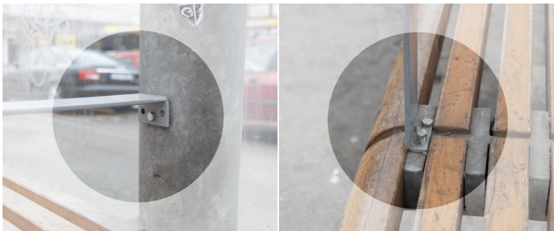
Obr. 55, 56: Detaily upevnění dělicích prvků ke konstrukci sezení
