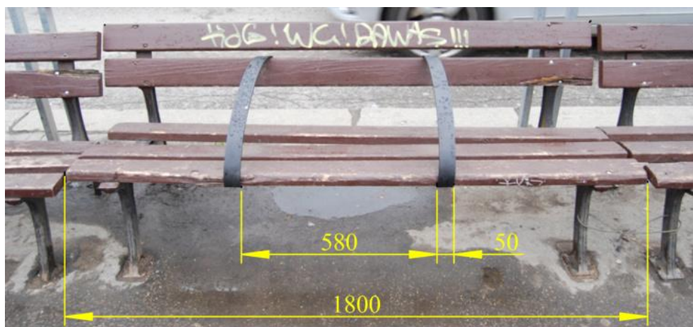
Obr. 3: Rozměry děleného prostoru na lavičce přednádraží v Brně
