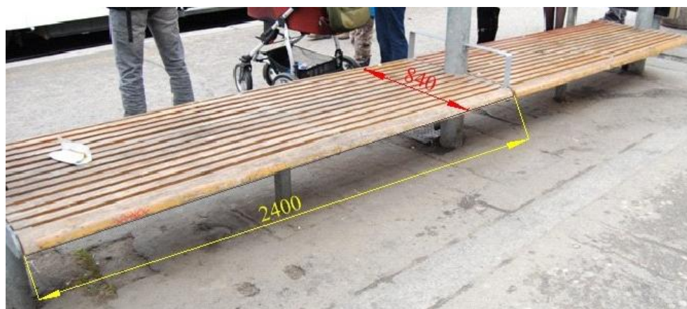
Obr. 59: Rozměry pro sezení po instalaci dělicích prvků
