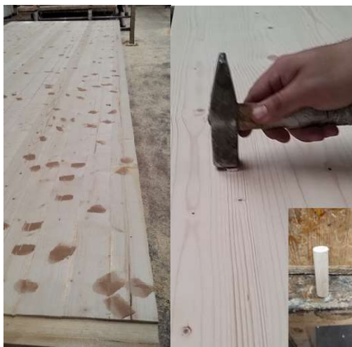
Obr. 15 Fáze oprav povrchu-Vyspravení tmelem (Využití hnědého tmele kvůli vzhledu CLT po žloutnutí UV dřeva) (vlevo). Oprava suků a nahrazení zdravými suký (tzv. vyspravení), Využití hnědého tmele kvůli vzhledu CLT po žloutnutí UV dřeva. (vpravo) (Foto: Autor)
