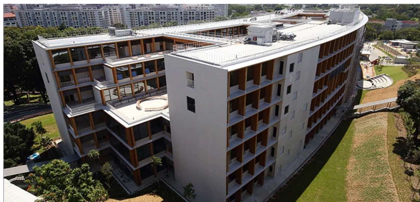
Obr. 26 (NTU ABS) Nanyang Technological University's Academic Building South ( Singapur)-Největší dřevostavbou v Asii (Steeltech Industries PTE Ltd, 2023)
