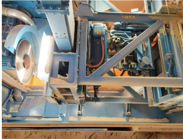
Obr. 17 Vytvoření finálního profilu CLT panelu pro montáž na stavbu je provedeno CNC obráběcí centru Hamuel Reichenbache-dle výrobní dokumentace (Foto:Autor)
