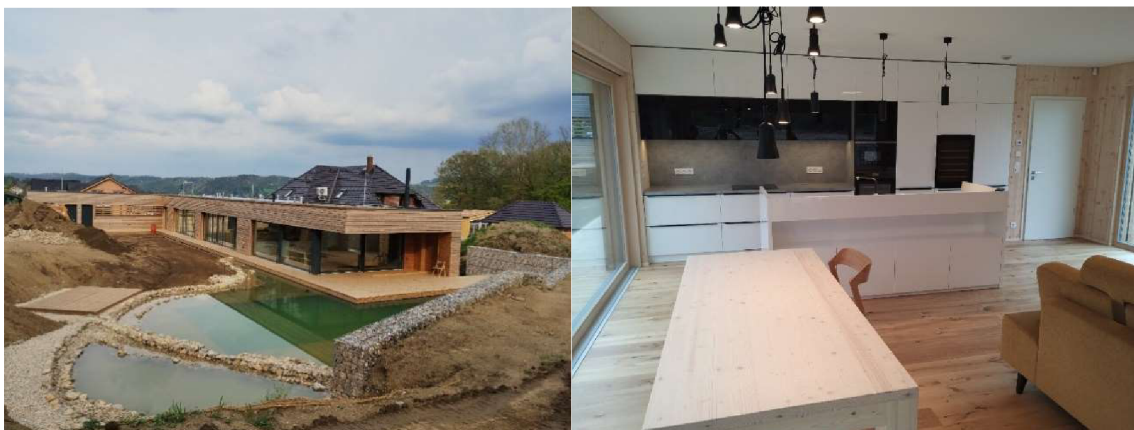
Obr. 23 Rodinný dům (Čerčany) ze systému Novatop realizované firmou 3AE s.r.o. Interiér domu z přiznaného Novatop systému (vpravo). (Foto: Autor)
