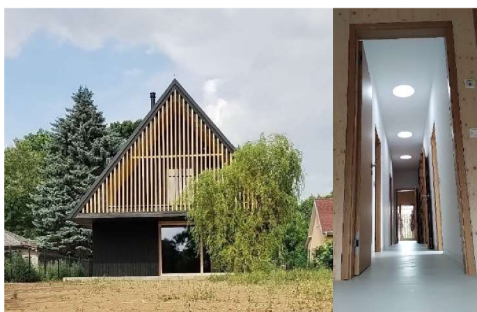
Obr. 24 Rodinný dům (Klecany) systém Novatop realizované firmou 3AE s.r.o. Interiér-přiznan Novatop (vpravo). (Foto: Autor)
