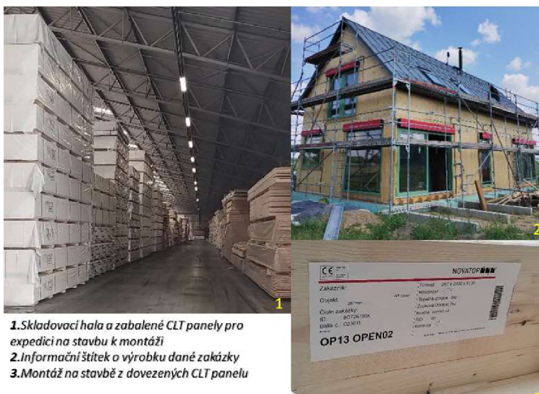
Obr. 21 Balení, skladování a expedice na stavenišť k montáži (Foto: Autor)
