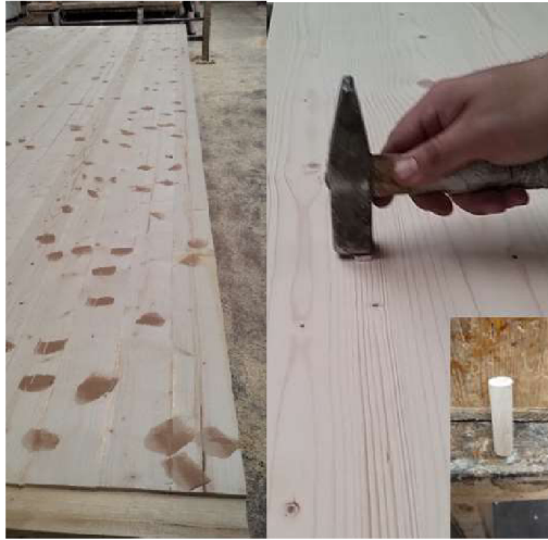
Obr. 15 Fáze oprav povrchu-Vyspravení tmelem (Využití hnědého tmele kvůli vzhledu CLT po žloutnutí UV dřeva) (vlevo). Oprava suků a nahrazení zdravými suký (tzv. vyspravení), Využití hnědého tmele kvůli vzhledu CLT po žloutnutí UV dřeva. (vpravo) (Foto: Autor)
