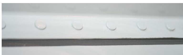
Obr. 24: Fazetkové tmelení a ochranný nátěr
