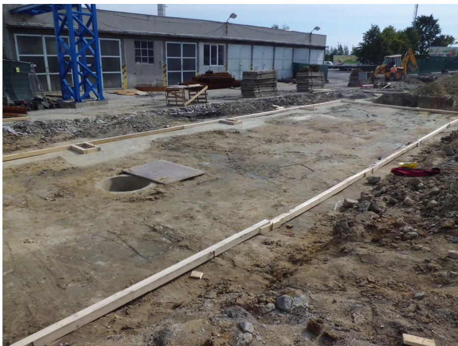
Foto 1: Zemní práce, zakládání
