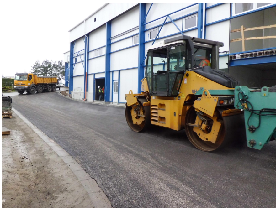
Foto 3: Oplá-t ní ocelového skeletu
