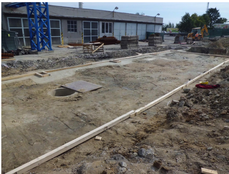
Foto 1: Zemní práce, zakládání
