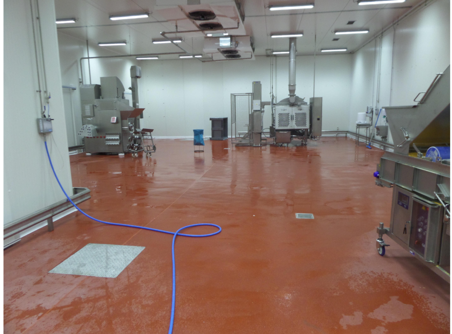
Foto 4: Interiér výrobní haly
