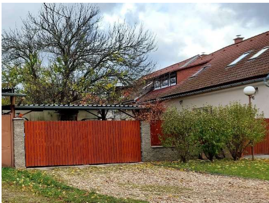
Obr. 39 Nesoulad č. 60 – Skutečný stav v terénu
