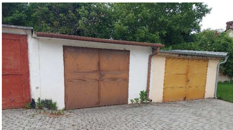
Obr. 44 Nesoulad č 53 – Skutečný stav v terénu
