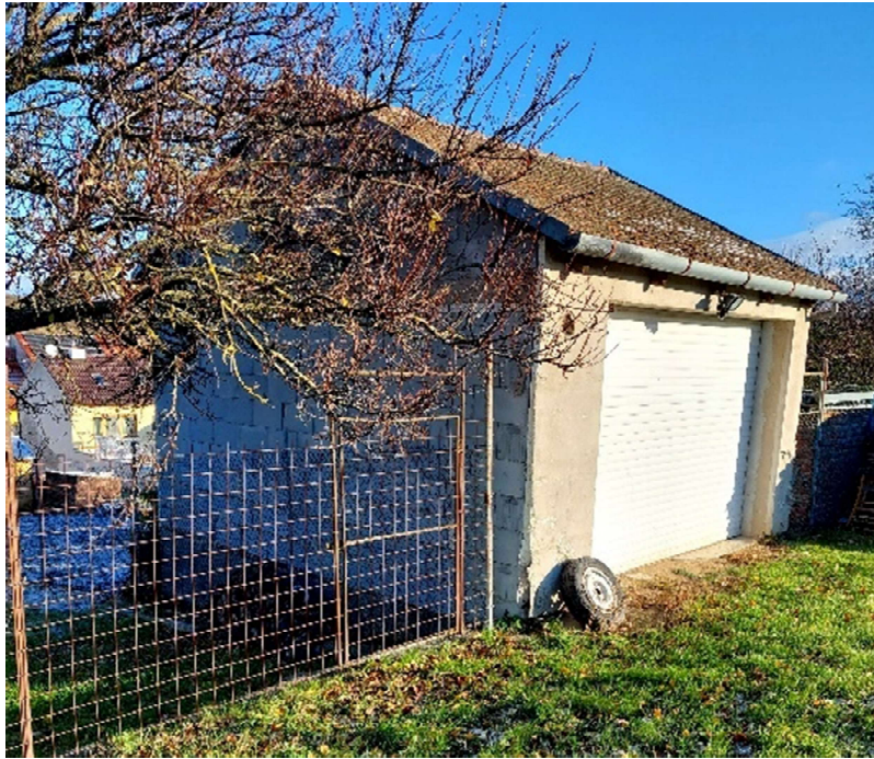
Obr. 36 Nesoulad č. 45 – Skutečný stav v terénu
