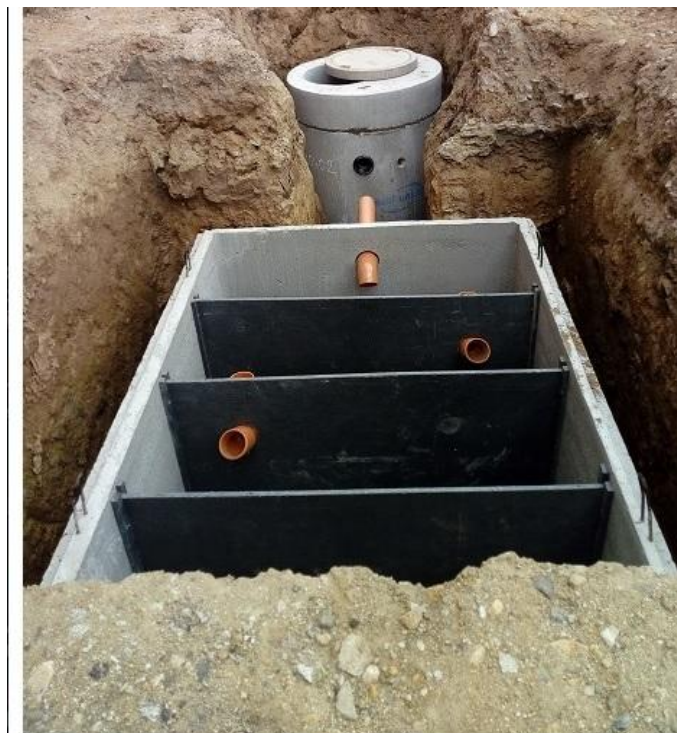
Obr. 2. Betonový septik čtyřkomorový (Jímky, 2017)
