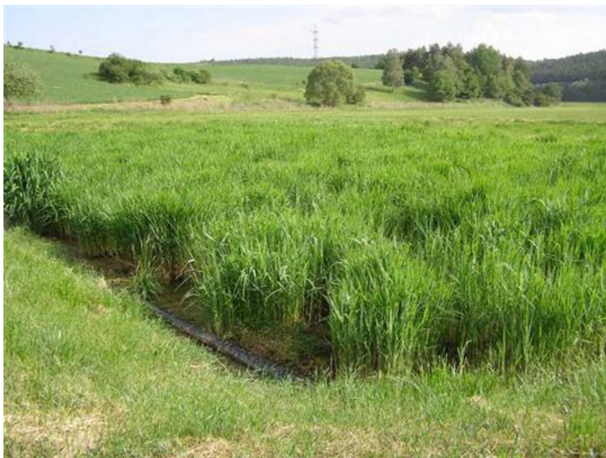
Obr. 8. ČOV – nádrž s rákosem. Foto obec Křoví
