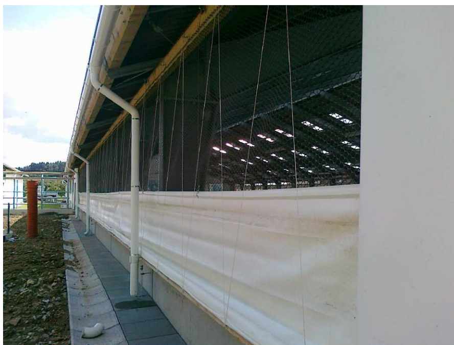
Obr. 2.1 Zavírání boků haly směrem od podlahy haly ke střeše
