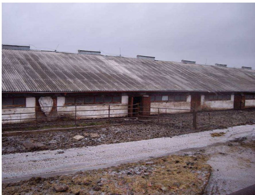
Obr. 3.3 Pohled na objekt určený k rekonstrukci
