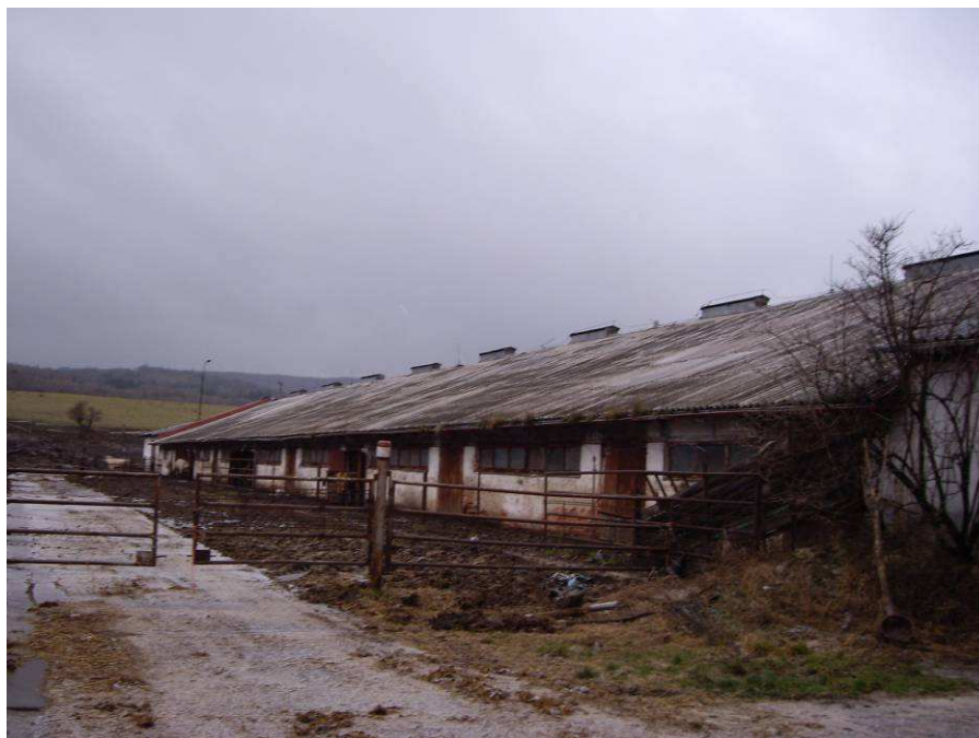
Obr. 3.8 Bok stavby (okna, vrat, ohrazený venkovní prostor)
