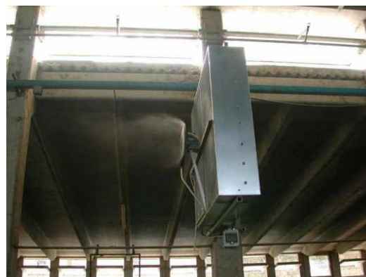
Obr. 2.11 Ochlazování vzduchu ve stáji - zmlžováním
