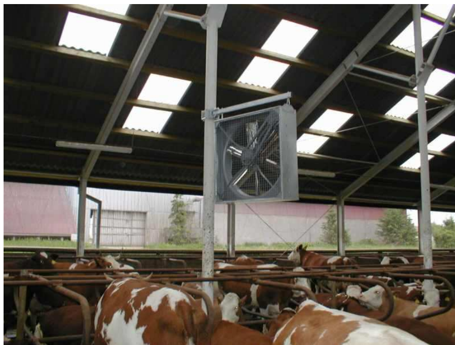
Obr. 2.8 Umístění vertikálního ventilátoru na konstrukci
