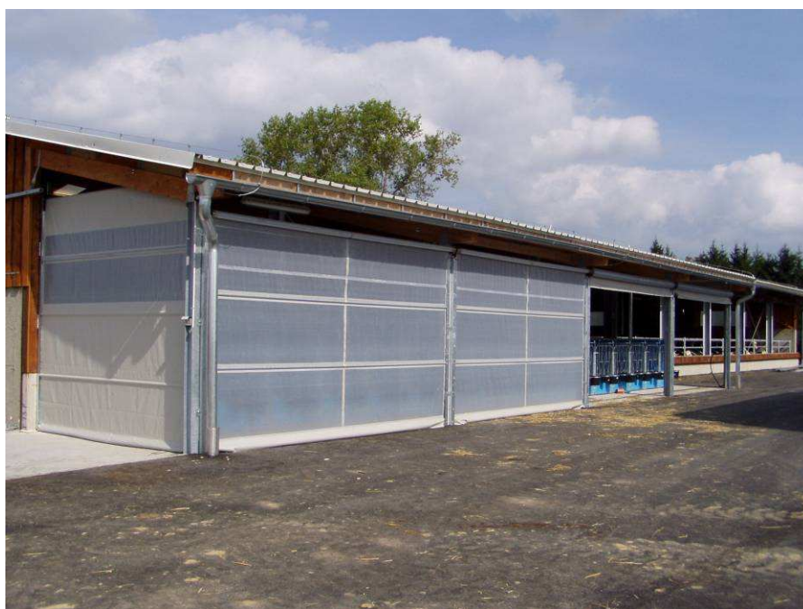
Obr. 2.2 Zavírání boků haly směrem od střechy dolů
