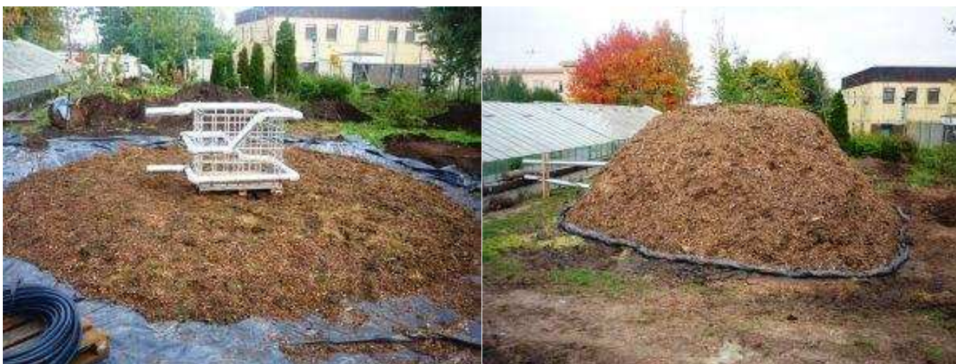
Obrázek 6 Základ biomilíře (vlevo) a konečná podoba reaktoru (vpravo) [17]
