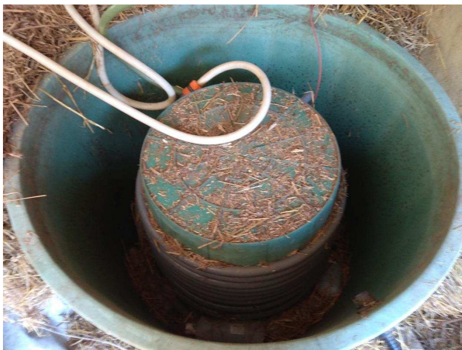
Obrázek 22 Detail na vnitřní výměník tepla bioreaktoru
