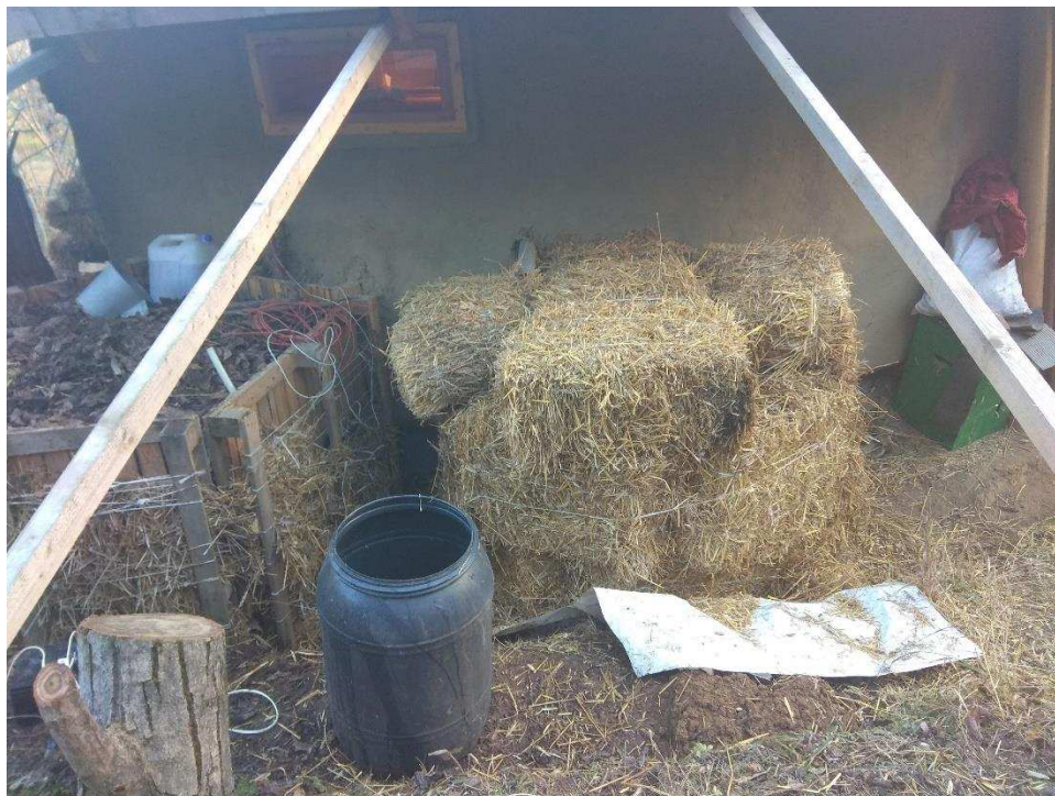
Obrázek 23 Kompletní bioreaktor i s opláštěním z balíků slámy
