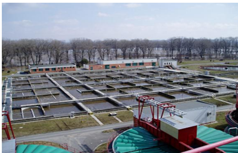
Obrázek 26: Celkový pohled na aktivační nádrže
