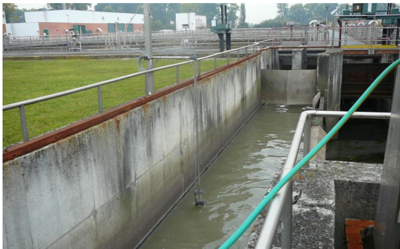
Obrázek 27: Přítok mechanicky předčištěné vody na proces aktivace
