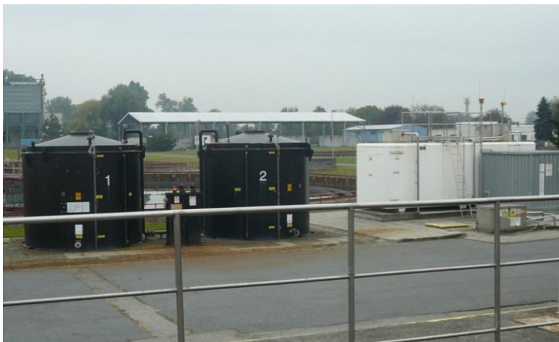
Obrázek 30: Zásobníky na metanol a síran železitý
