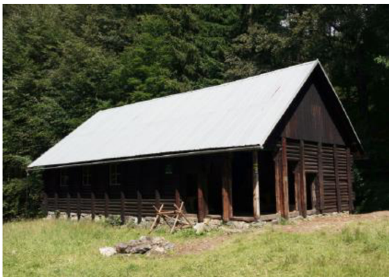
Chata Srub – celkový pohled
