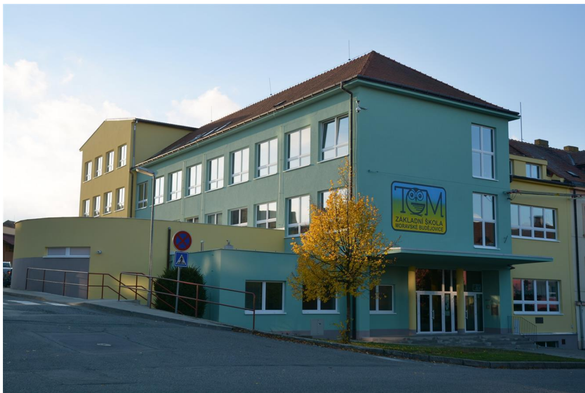
Příloha 3 - Základní škola T. G. Masaryka v Moravských Budějovicích – budova „A“ (současný stav)
