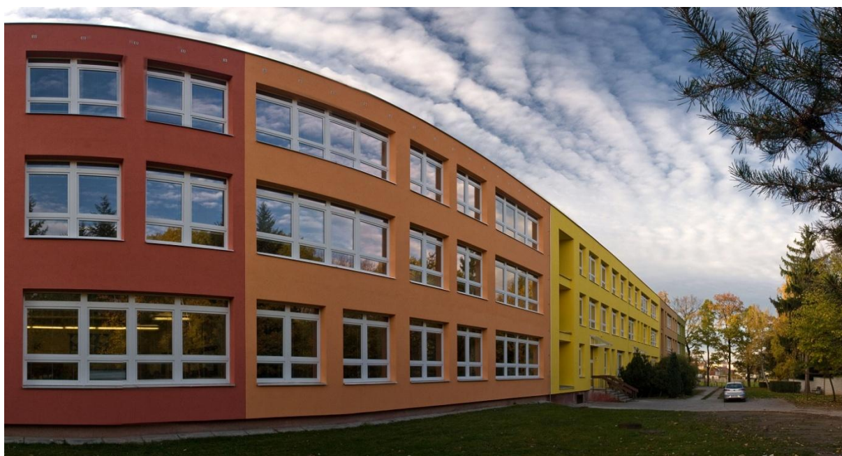
Příloha 2 - Základní škola Moravské Budějovice, Havlíčkova ulice č. p. 933 (současný stav)
