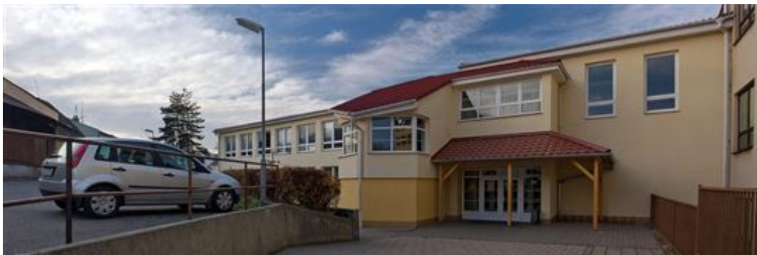
Příloha 4 – Základní škola T. G. Masaryka v Moravských Budějovicích – budova „B“ (současný stav)
