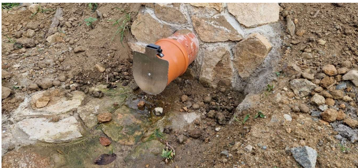
Obrázek 35: Příklad výustního objektu v obci Hlína
