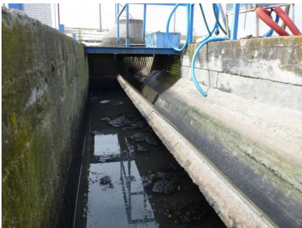
Obrázek 11: Horizontální lapák písku (sdružený objekt s ručně stíranými česlemi)
