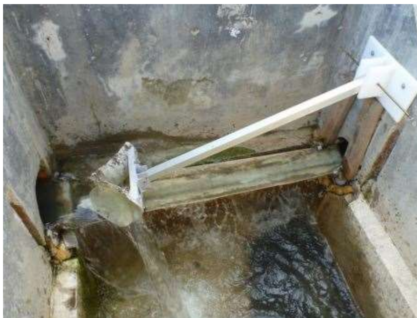
Obrázek 7: Odlehčovací komora s oboustranným bočním přelivem [6]
