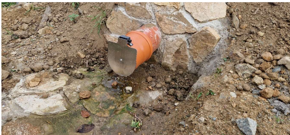
Obrázek 35: Příklad výustního objektu v obci Hlína
