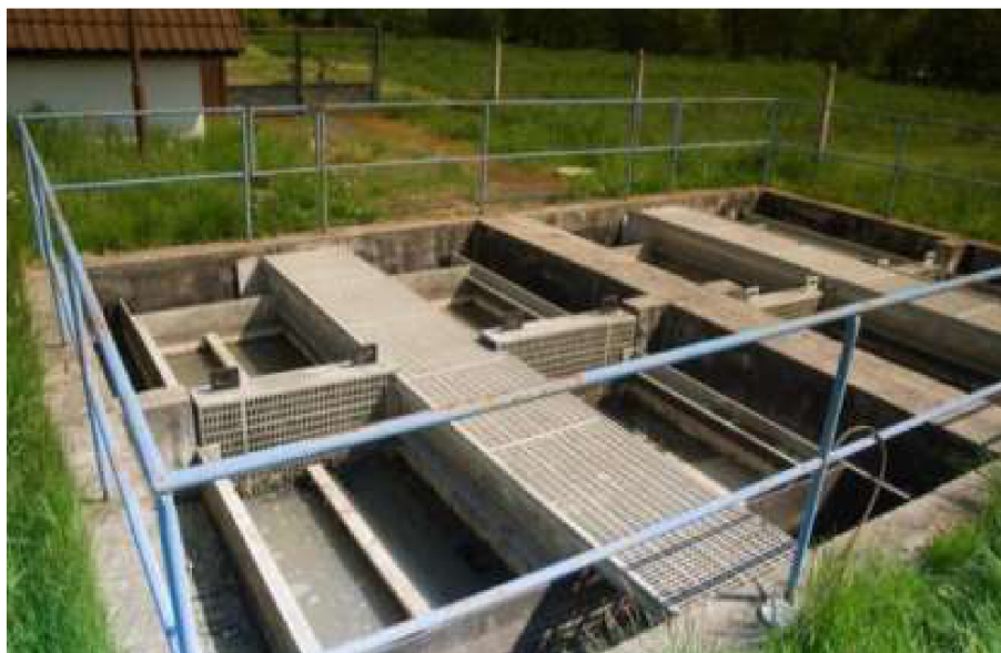
Obrázek 12: Odkrytá štěrbinová usazovací nádrž s bezpečnostním filtrem [2]
