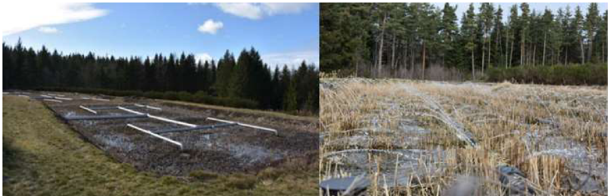
Obrázek 18: Vlevo první stupeň, vpravo druhý stupeň Francouzského systému [4]
