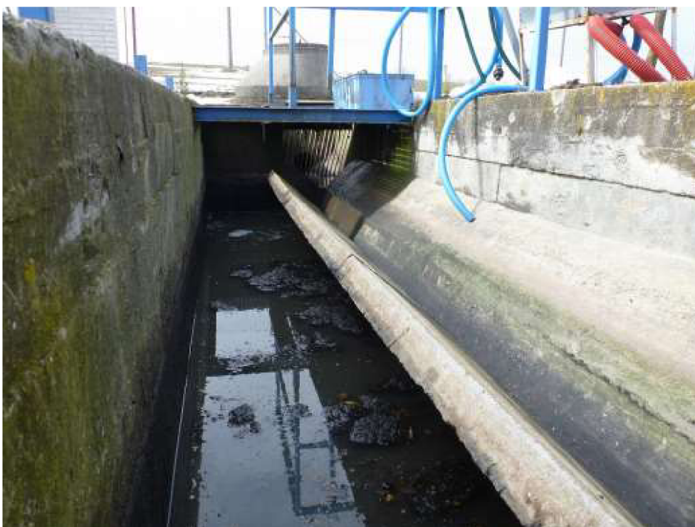
Obrázek 11: Horizontální lapák písku (sružený objekt s ručně stíranými česlemi)
