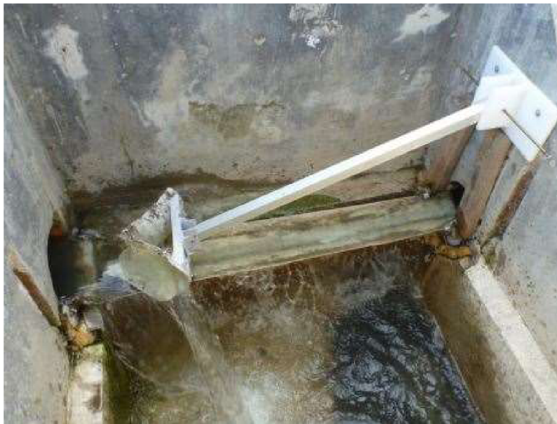
Obrázek 7: Odlehčovací komora s oboustranným bočním přelivem [6]
