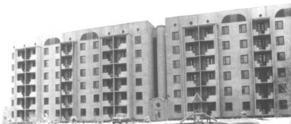
Obrázek 1 Bytový dům postavený v roce 1990 z popílkového a struskového alkalického betonu v Rusku ve městě Novokuznetsk [7].
