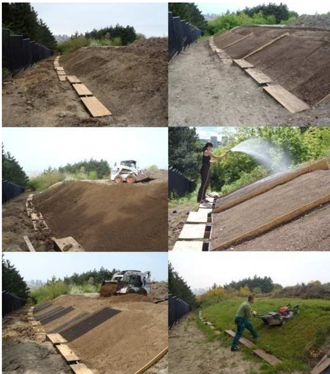
Obr. 6 Postup založení pokusných ploch a následná péče – instalované sedimentační nádrže a vysvahované plochy (levý horní roh), ohumusování ornící (vlevo uprostřed), položené GMA a následné prosypání (levý dolní roh), oseté a zaválcované pokusné plochy (pravý horní roh), pravidelná zálivka (vpravo uprostřed), kosení ploch (pravý dolní roh).
