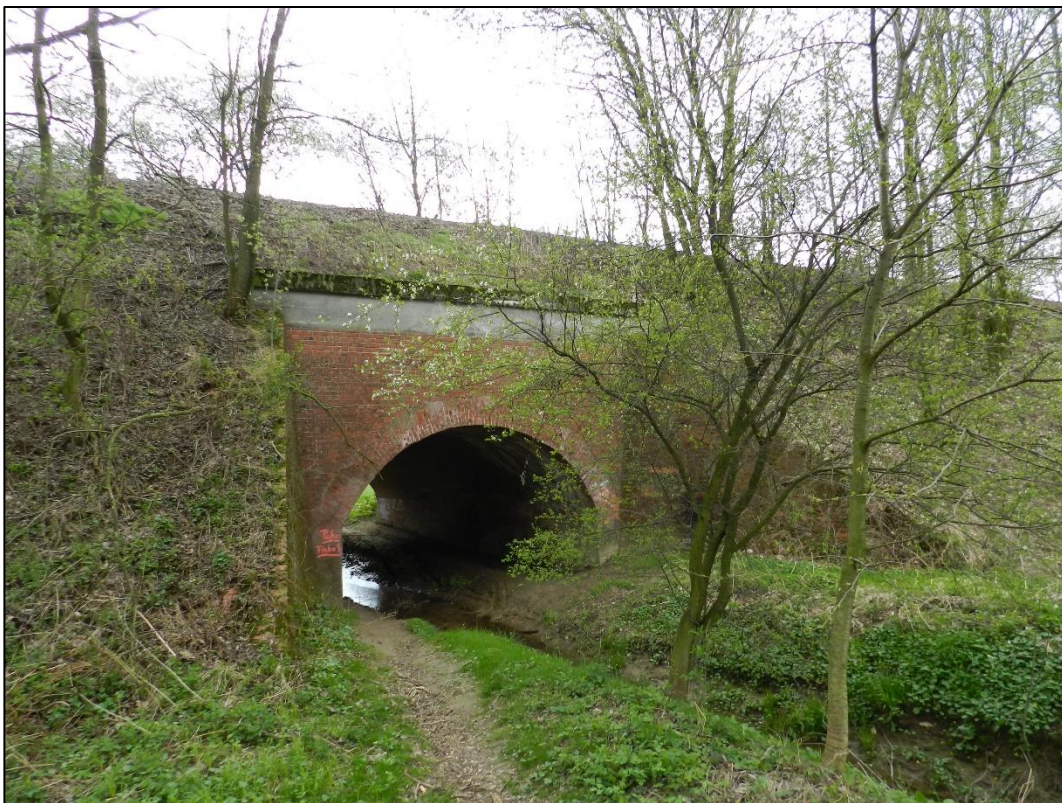
Obr. 17 Železniční most přes Chlebičovský potok (foto: Englischová Aneta, 8. 4 2017)
