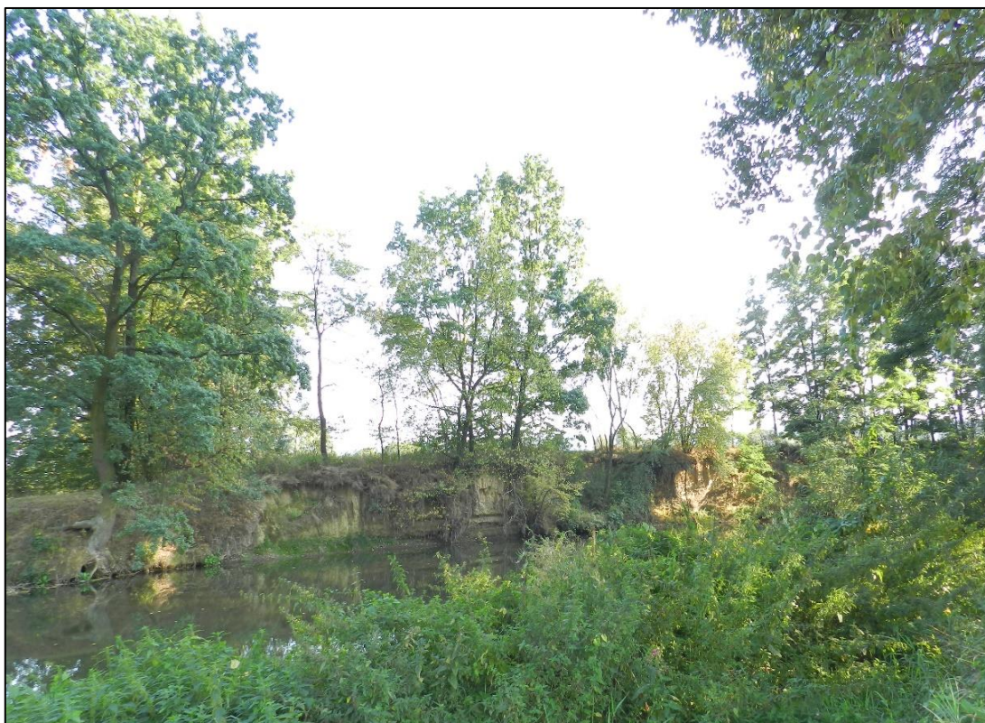
Obr. 3 Pokračování břehové nátrže na řece Opavě u jezu Lhota (foto: Englischová Aneta, 15. 9. 2016)
