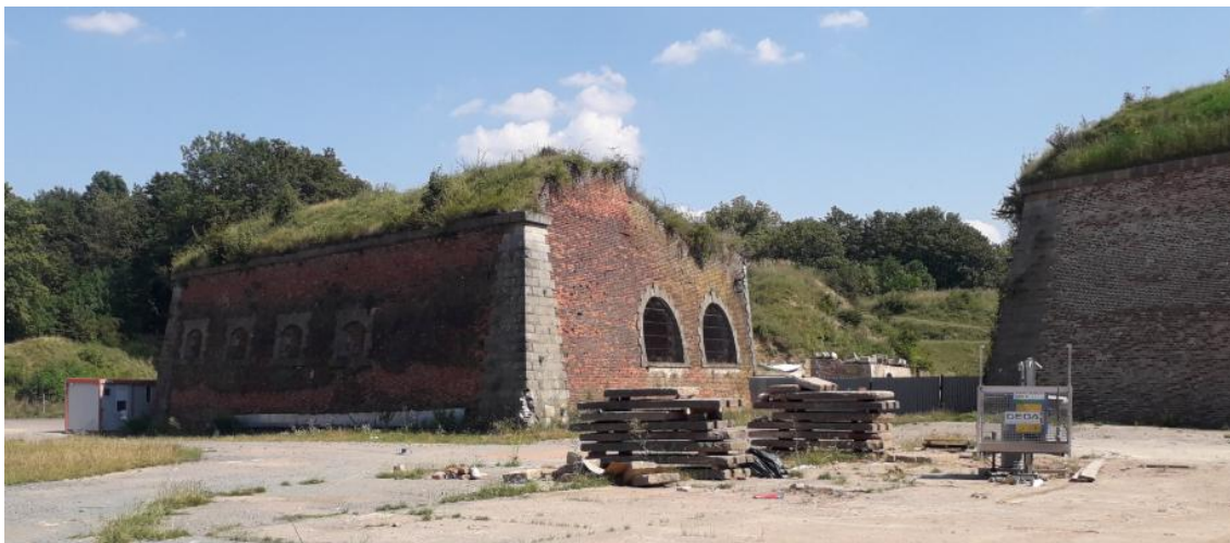
Obrázek 3: Rekonstrukce bastionů barokní pevnosti Josefov
