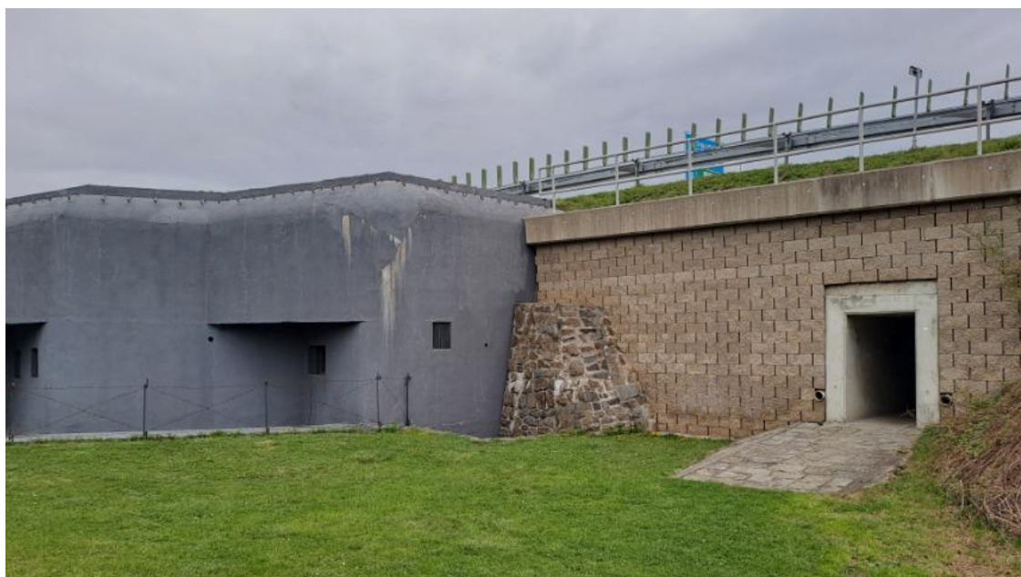
Pohled na levou část objektu
