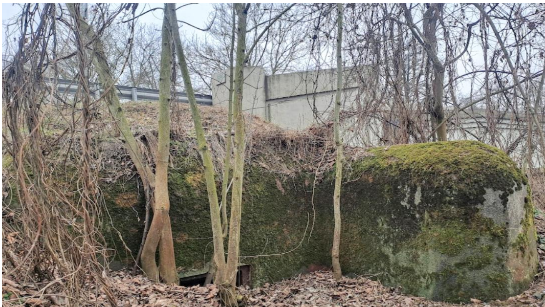
Obrázek 40: Uzamčený objekt lehkého opevnění E-24/5/D1 Holýšov
