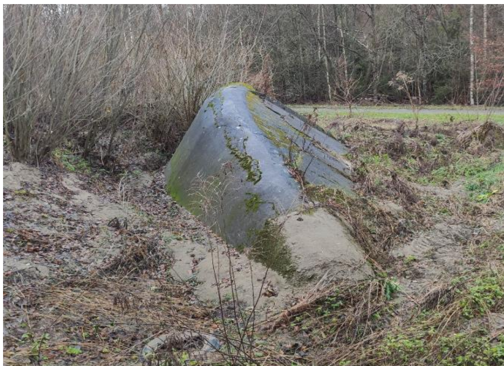
Obrázek 56: Objekt XXI/724/A-200Z po povodni (Bukovský, 2024)
