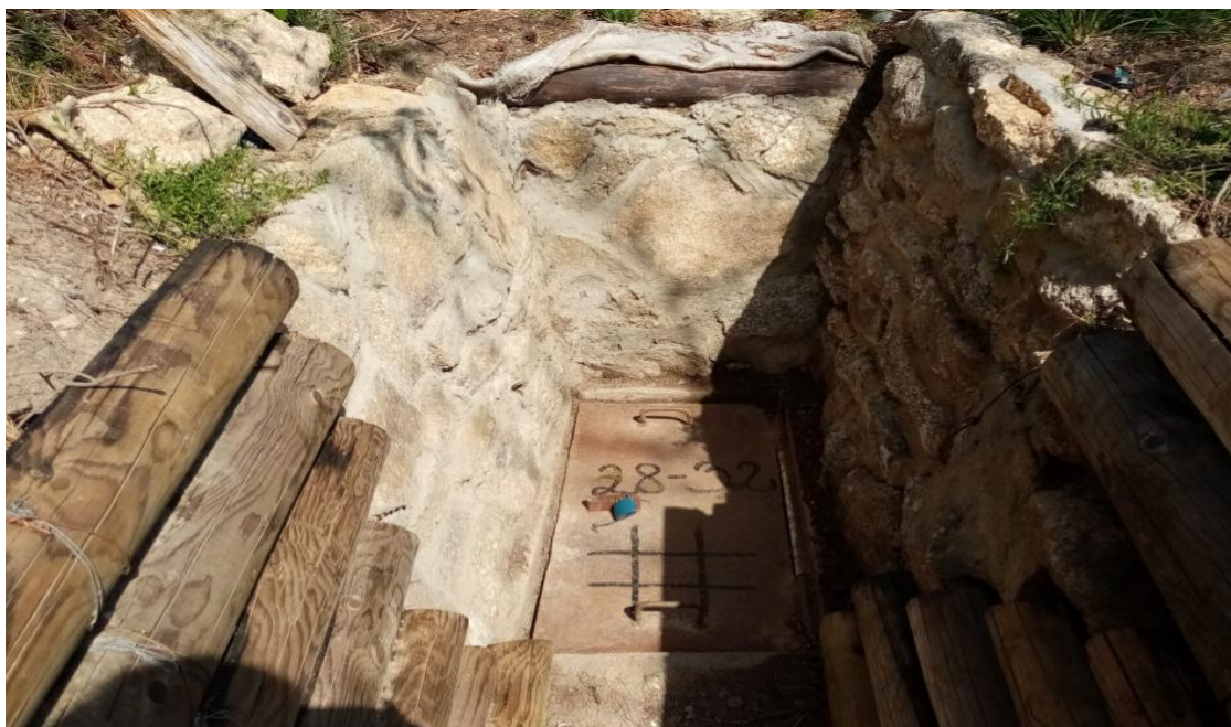
Obrázek č. 35: Jemnice/1/C 160 – vstup do řopíku (ESCAPEROPIK, ©2025)
