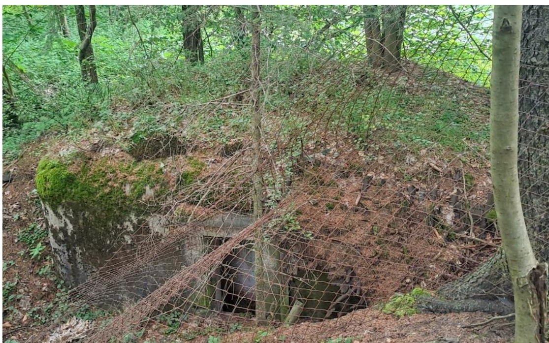
Obrázek 60: Nezabezpečený objekt lehkého opevnění – G2/281/E (Příloha 35)
