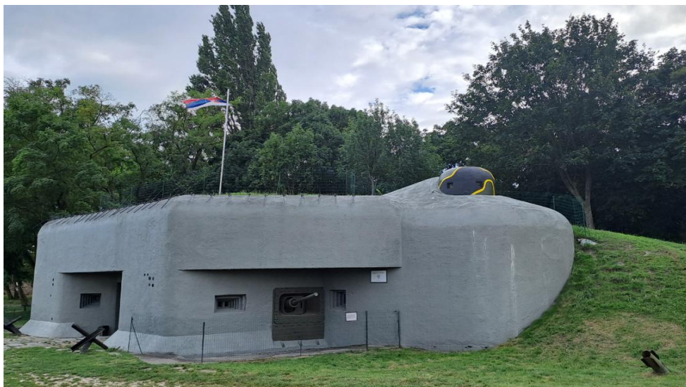
Obrázek 25: Izolovaný pěchotní srub B-S 8 „Hřbitov“
