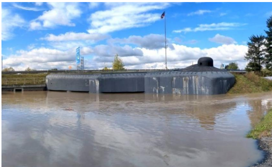
Obrázek 18: Objekt MO-S 5 „Na trati“ – povodeň září 2024
