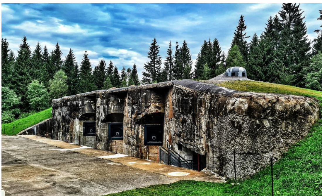
Srub „Na mýtině“ (Tesař, 2020)
