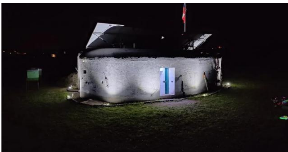
Obrázek 46: Bunkr „Čertík“ se solárními panely (ROPIK-3107, ©2022)
