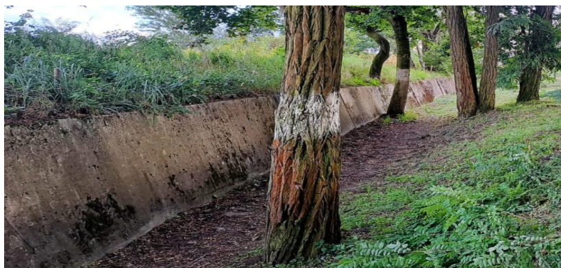
Obrázek 14: Protitankový příkop na ochranu srubu na úseku Bratislava
