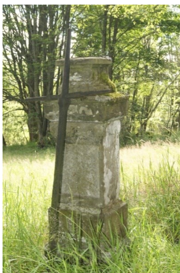
Obrázek 11 – Špatný stav kříže
