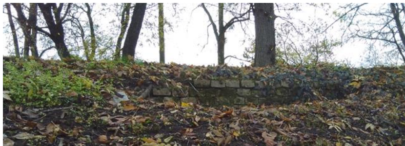
Obrázek 19: Pozůstatek původní zdi hřbitova
