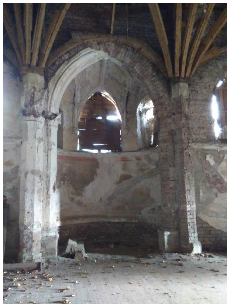
Obrázek 29: Vnitřek obřadní síně v Břeclavi
