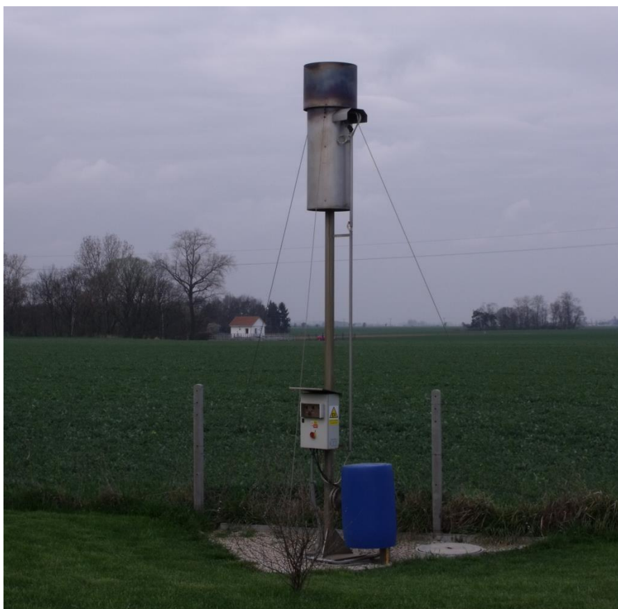
Příloha 8: BPS Lhota pod Libčany, hořák zbytkového plynu („fléra“). Foto: Adam Prousek, 2014
