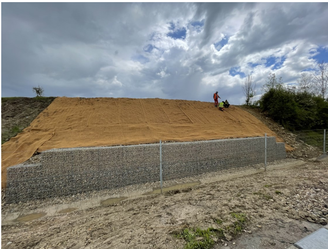
Obr. 29: Foto poškozený svah - průběh prací (autorka, 2020)
