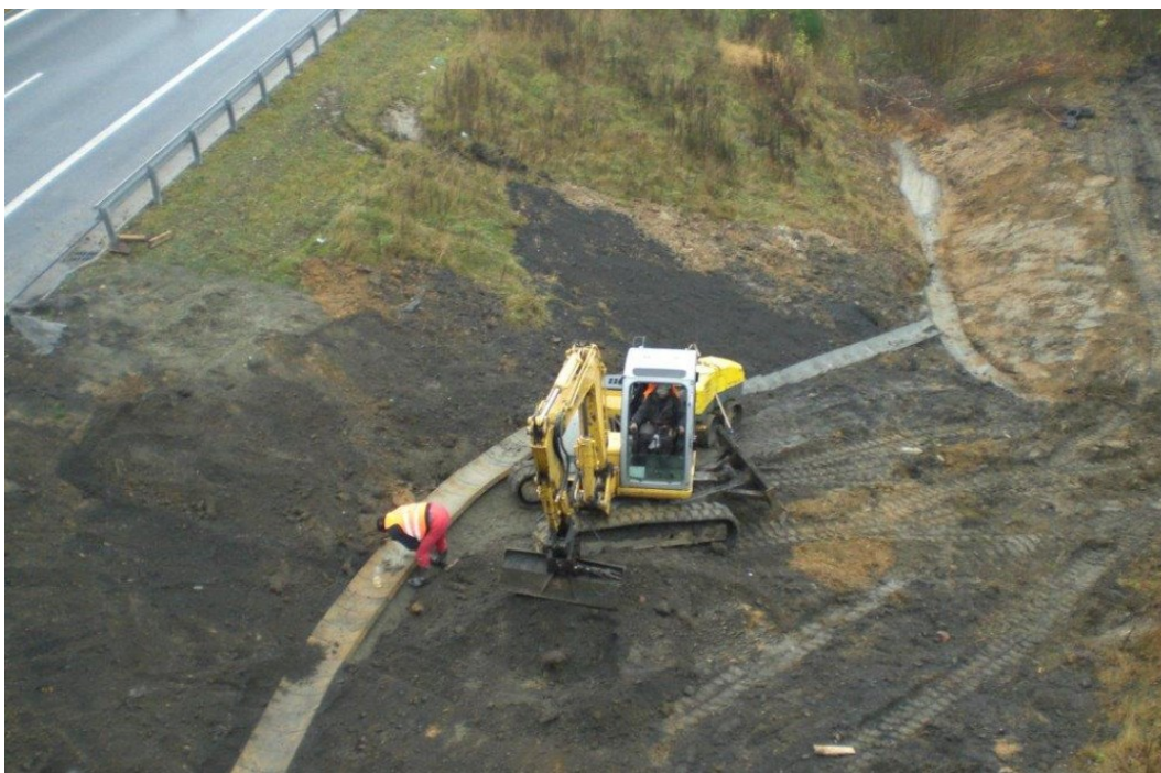
Obr. 19: Foto z průběhu práce - listopad 2013 (záznam ŘSD)
