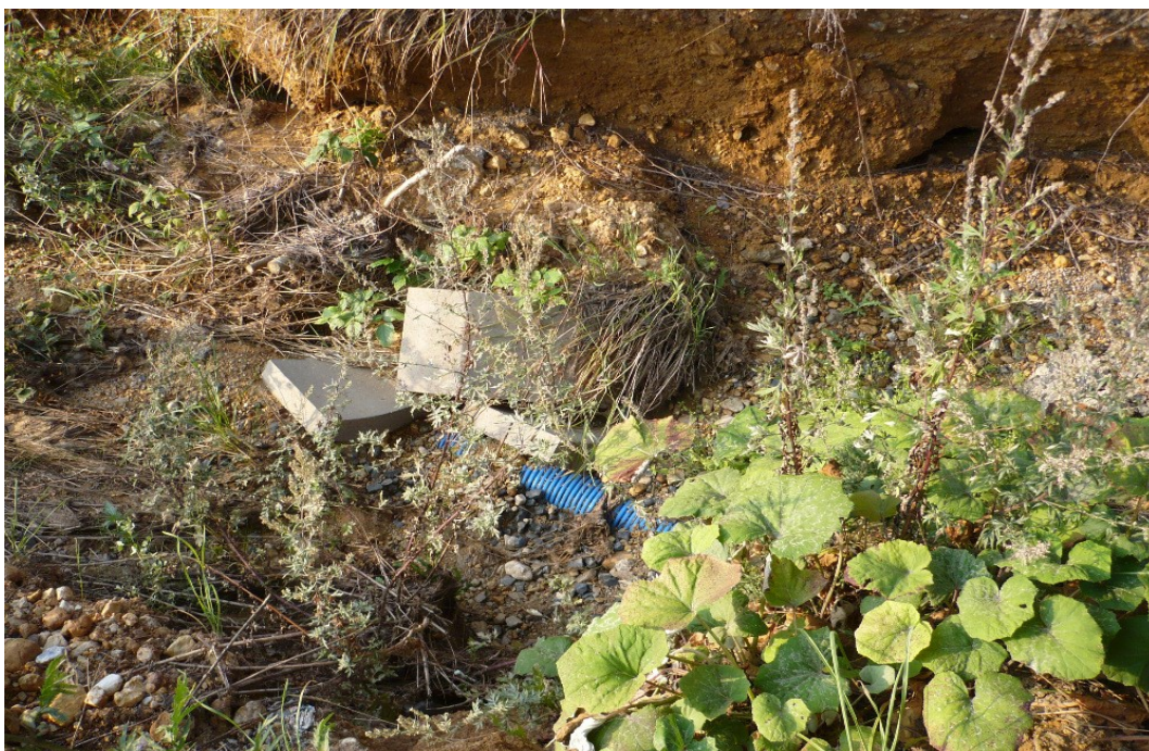
Obr. 17: Foto poškozeného svahu /odvodnění/ - srpen 2013 (záznam ŘSD)
