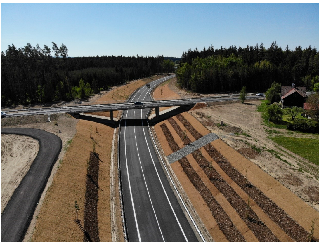
Obr. 32: Foto Obchvat Trstěnice - Drmoul, sil. I/21 - založení vegetace rok 2020 (autorka 2020)
