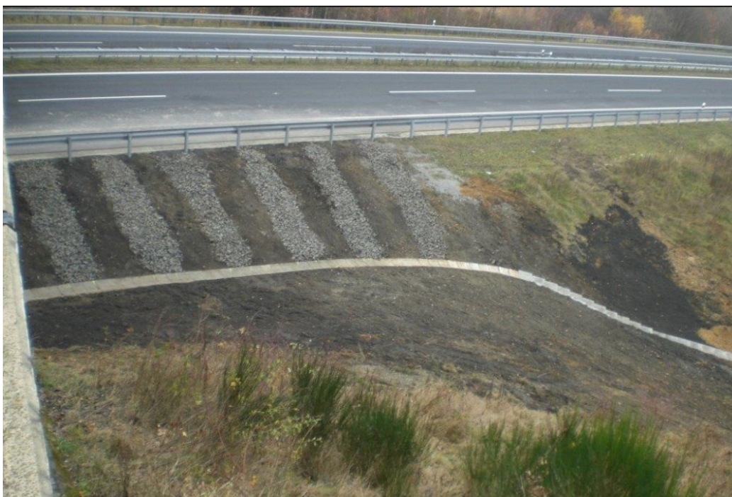
Obr. 20: Foto sanace, vč. odvodnění - listopad 2013 (záznam ŘSD)
