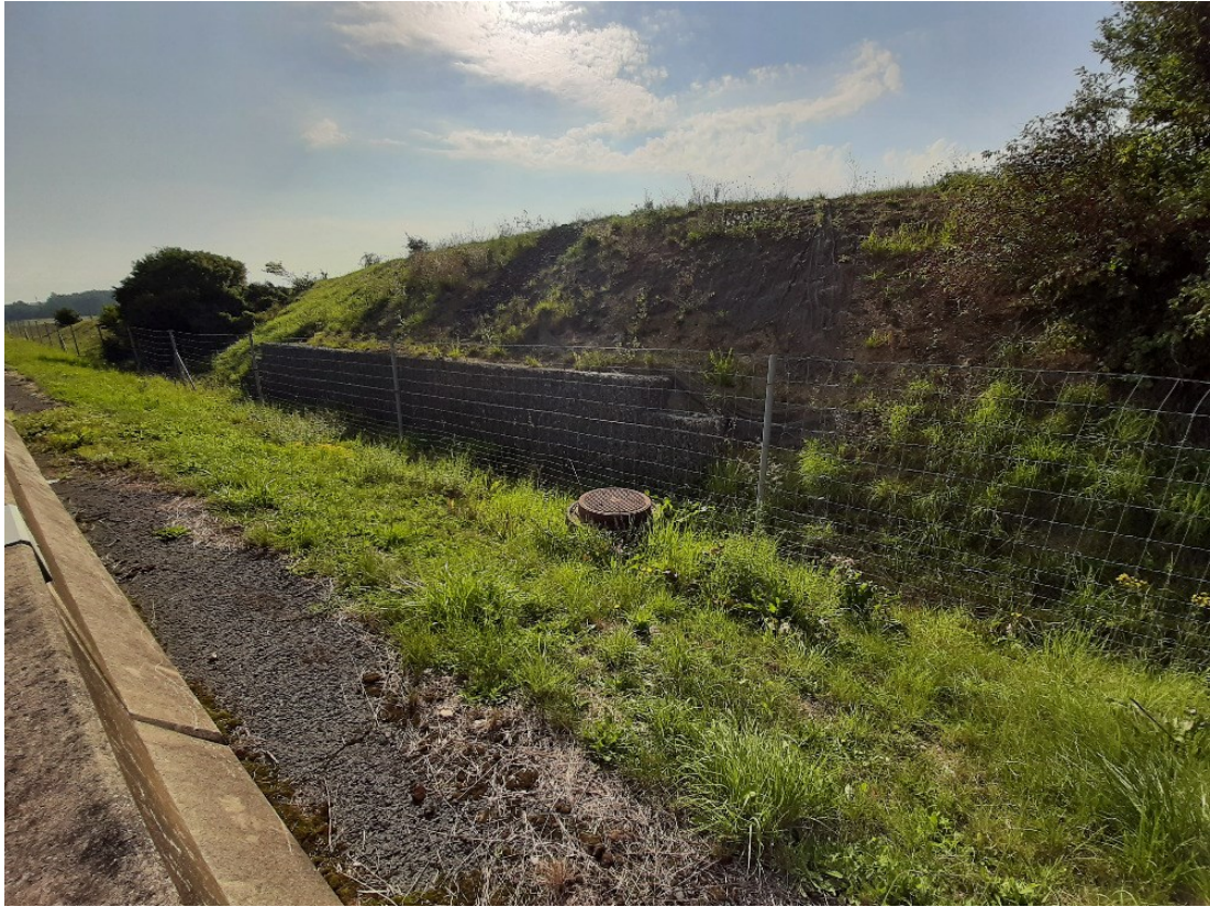
Obr. 30: Foto sanace svahu (autorka, 2023)
