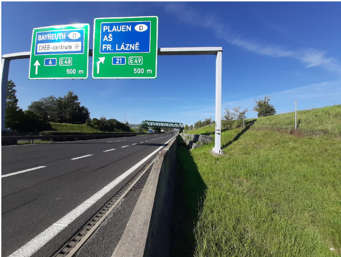
Obr. 24: Foto gabionové zdi u železničního mostu (autorka, 2023)
