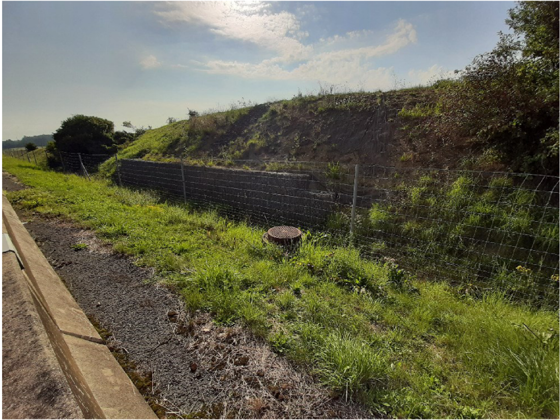
Obr. 30: Foto sanace svahu (autorka, 2023)
