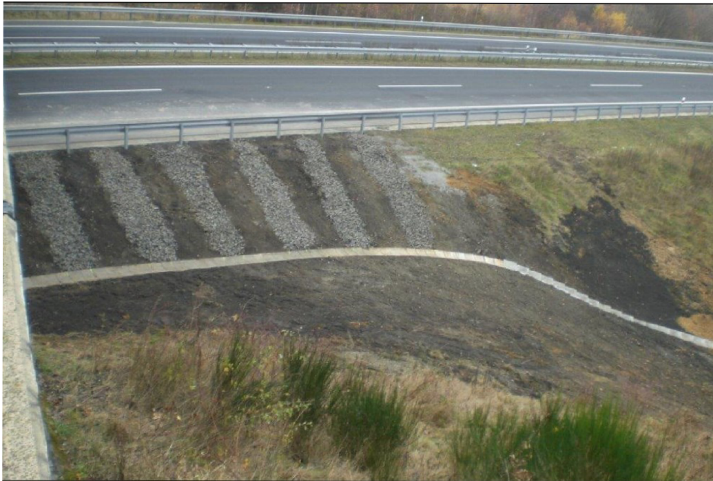
Obr. 20: Foto sanace, vč. odvodnění - listopad 2013 (záznam ŘSD)
