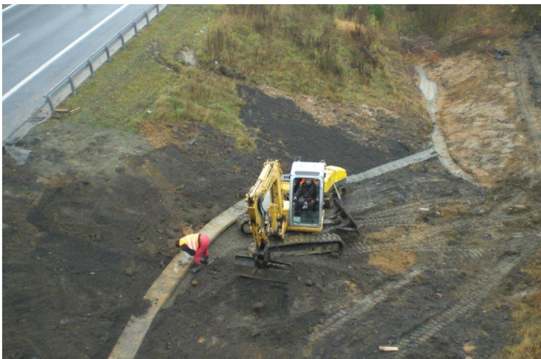
Obr. 19: Foto z průběhu práce - listopad 2013 (záznam ŘSD)
