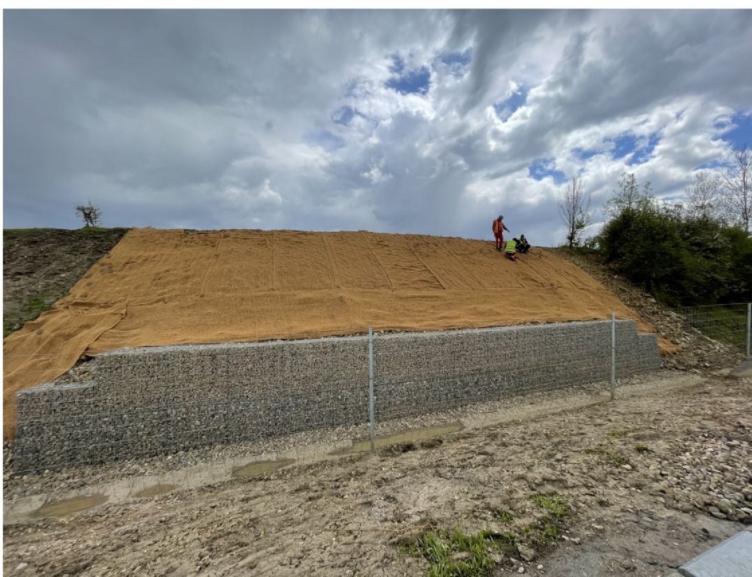
Obr. 29: Foto poškozený svah - průběh prací (autorka, 2020)
