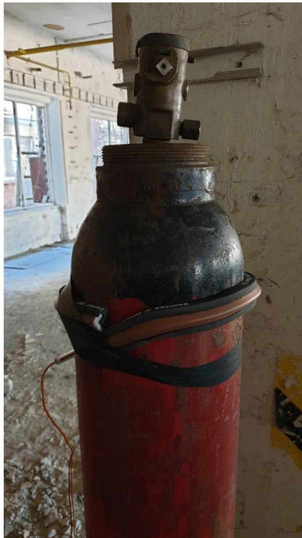
Obr. 9 Likvidace tlakové láhve – příprava (SEMTEX RAZOR) (zdroj vlastní)
