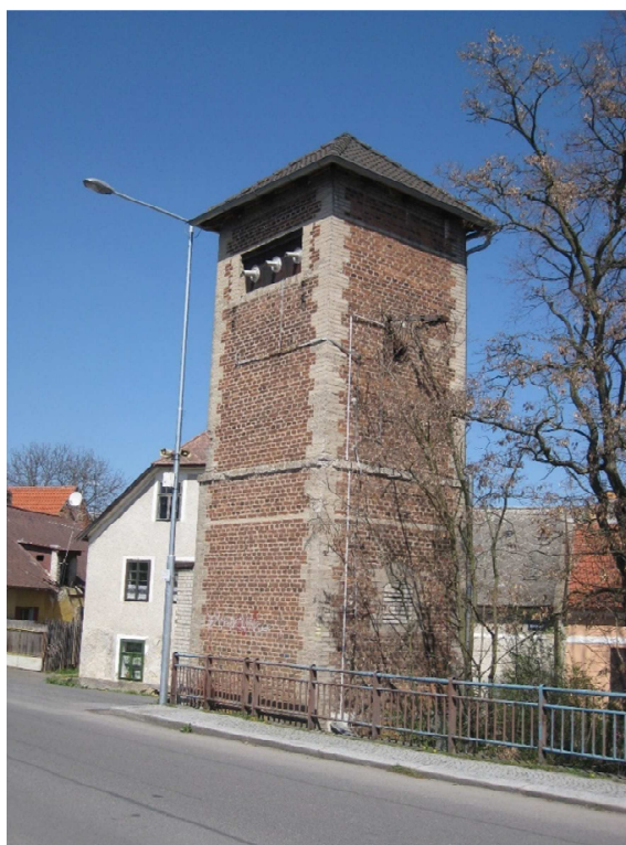
Příloha 55: Věžový transformátor v obci Rožmitál pod Třemšínem v roce 2019. 484
