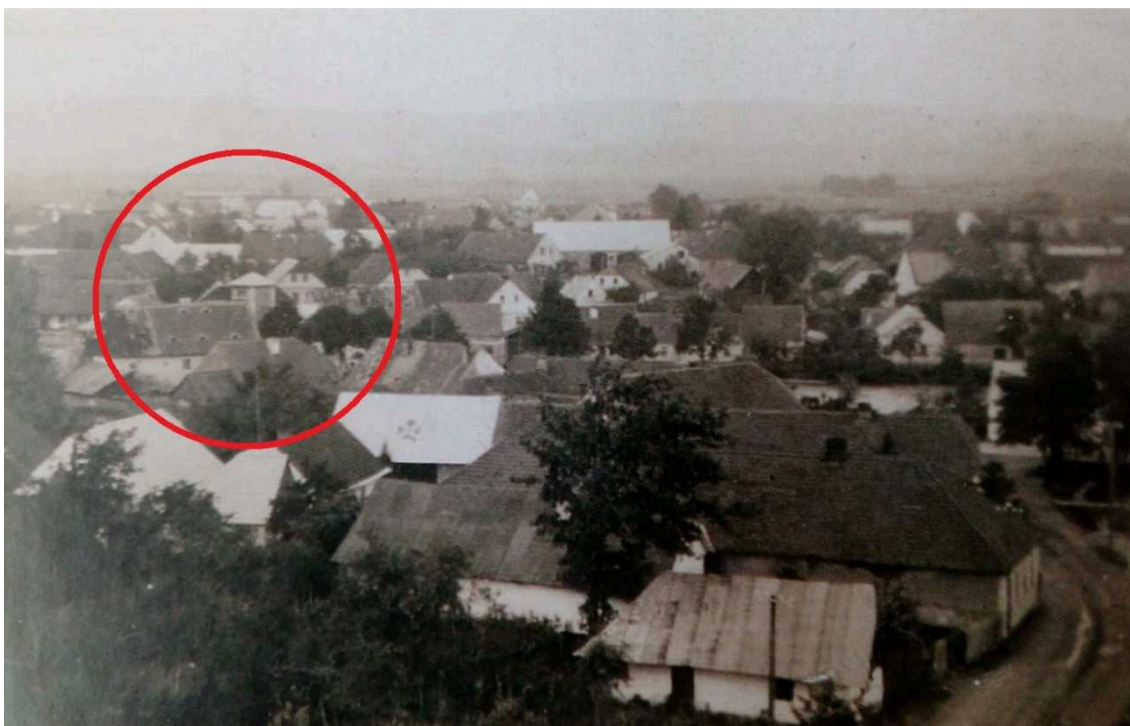
Příloha 54: Fotografie z roku 1927 zachycující věžový transformátor v obci Rožmitál pod Třemšínem. 483
