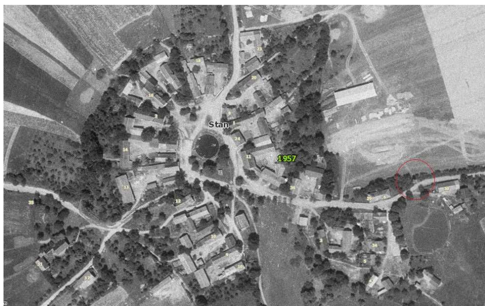
Příloha 28: Ortofoto snímek obce Stan z roku 1957 ještě s transformační stanicí vpravo v červené kružnici. Trafostanice byla zbourána. 457
