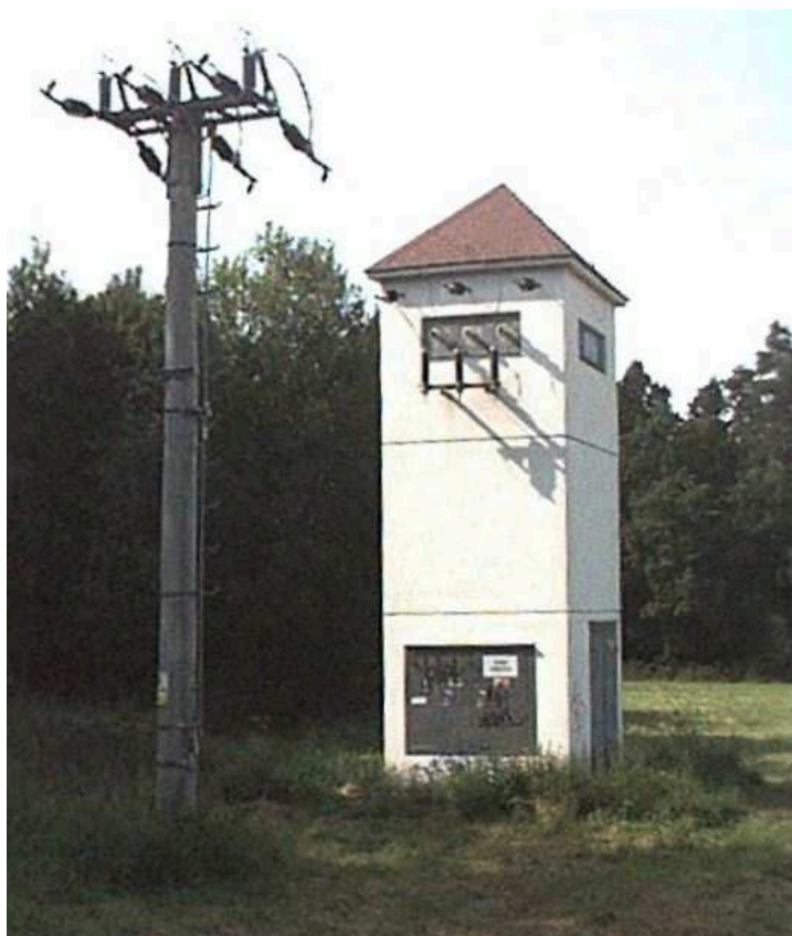
Obr. 6: Zachovalý zděný transformátor u obce Včelná. 355
