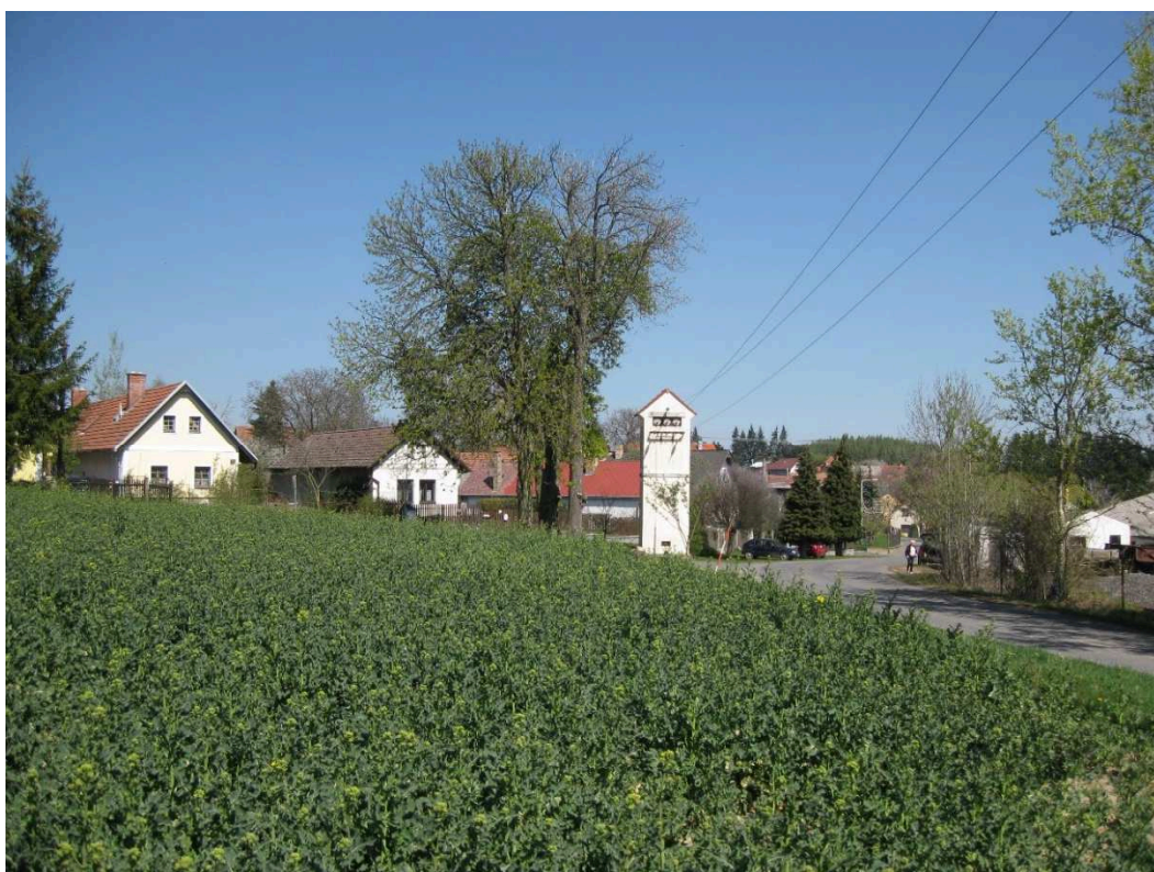
Příloha 53: Věžový transformátor v obci Vševily v roce 2019. 482
