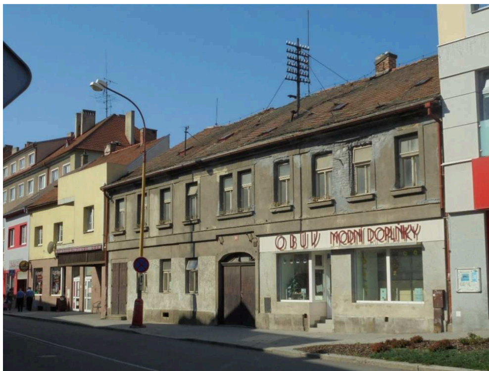
Příloha 47: Zachovalý střešník v centru Milevska. 476
