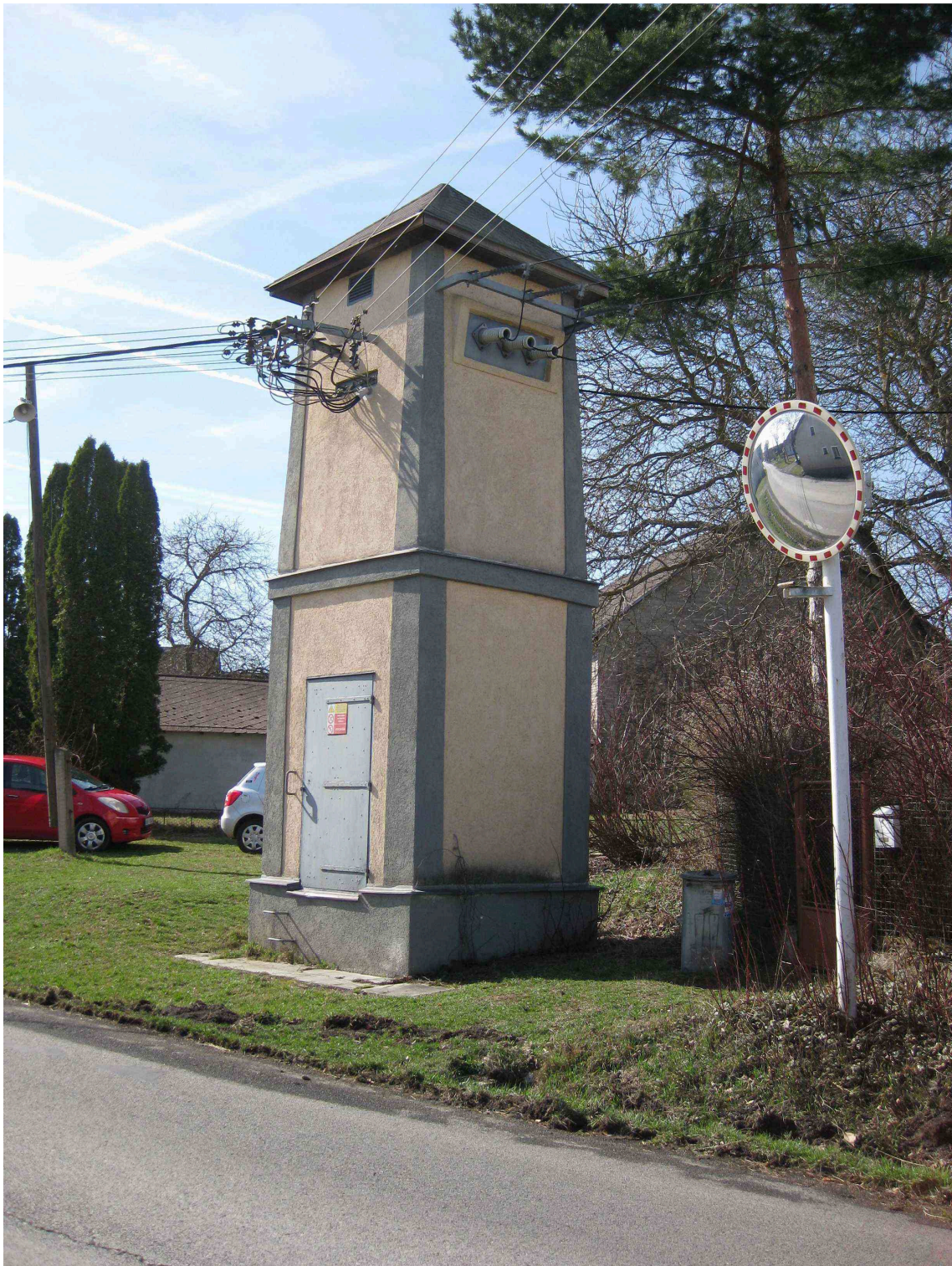
Příloha 58: Dochovaný funkční věžový transformátor v obci Sirá. 489 Zapojení transformátoru provedl Ing. R. Keclík z Prahy v roce 1935. 490
