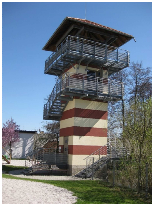
Příloha 34: Věžový transformátor vybudovaný v 50. letech 20. století, přestavěný na rozhlednu. 463
