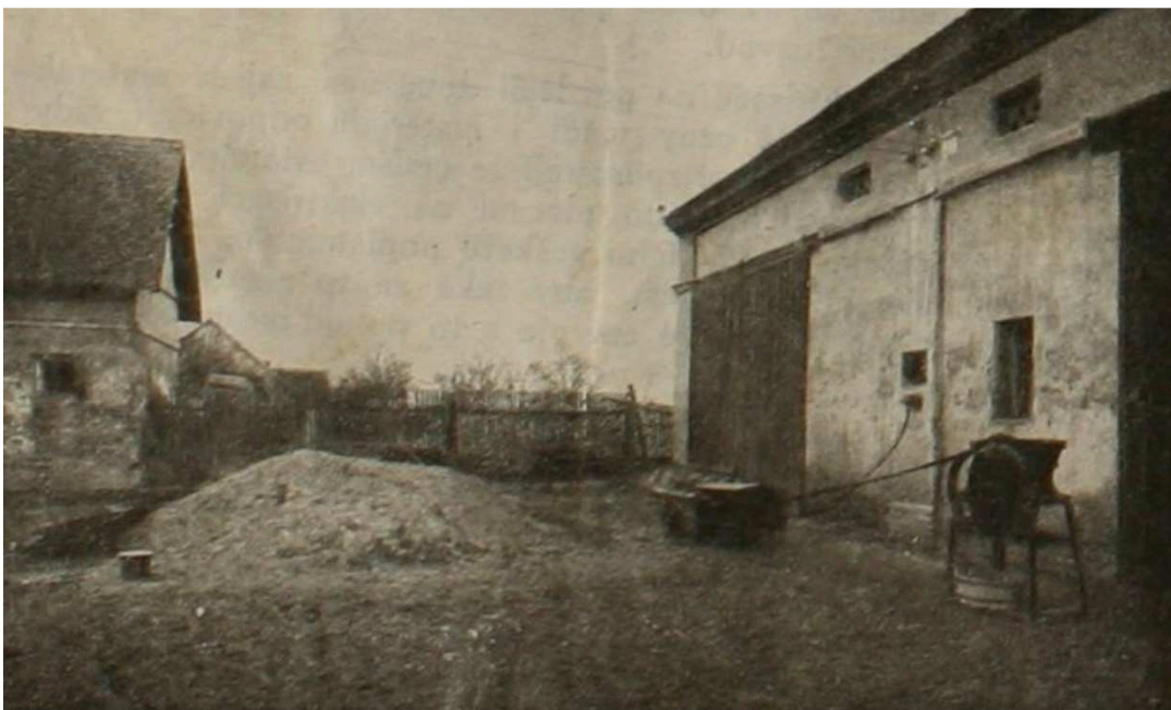
Příloha 24: Krouhačka řepy, poháněná elektromotorem. Na fotografii je vidět přívod nadzemního vedení do domu. Pod přípojkou je vývod pro zapojení elektromotoru, který pohání krouhačku. 453
