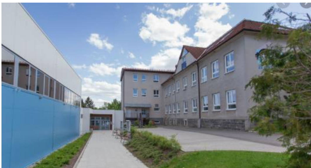
Obr. č. 8 Budova školy s tělocvičnou, pohled ze dvora
