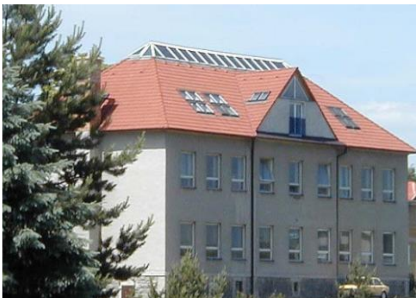
Obr. č. 7 Současná budova školy
