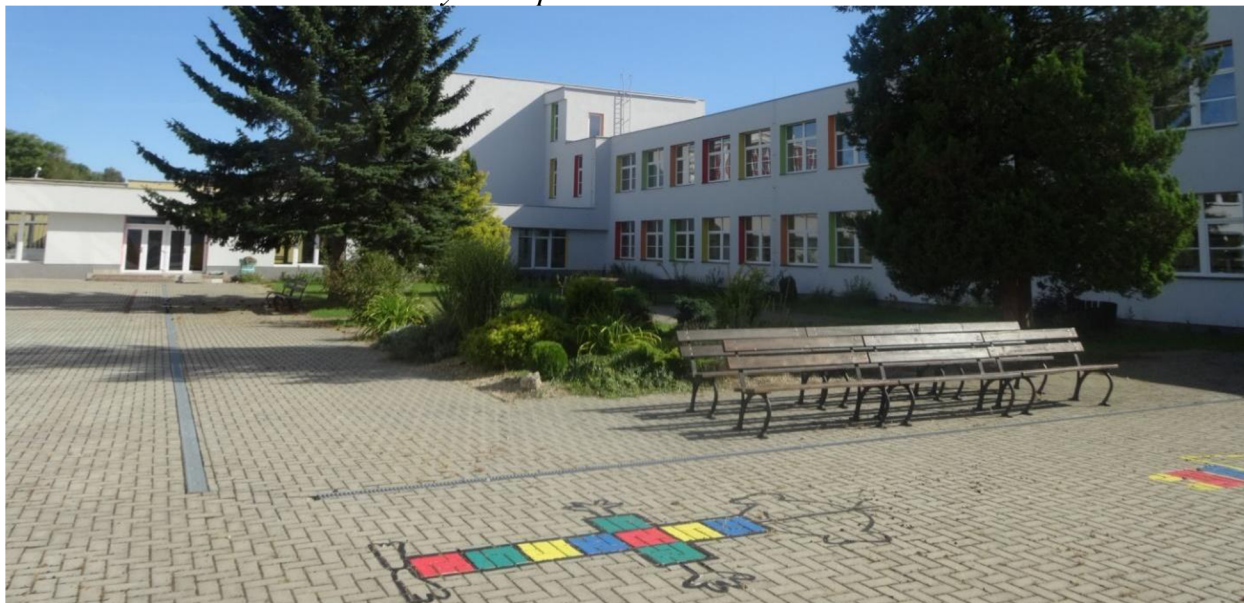
Obrázek 8 - Budova Základní školy Stráž pod Ralskem
