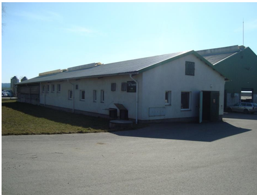
Obr. 1.1 – Pohled na dojírnu
