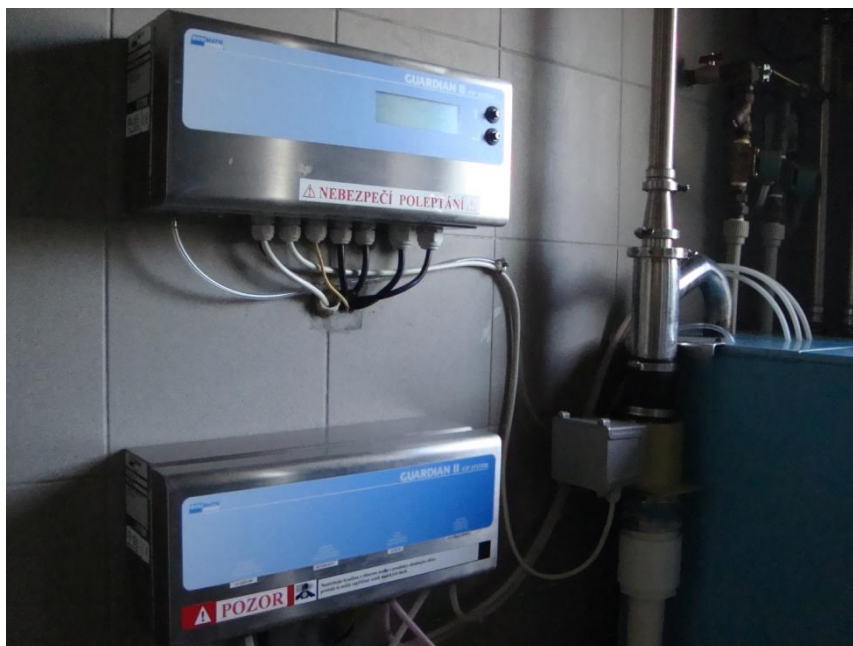
Obr. 1.16 – Zařízení k automatickému dávkování chemikálií pro proplachy (Guardian II)
