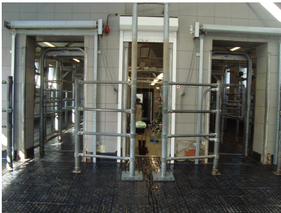
Obr 1.5 – Vstupy z čekárny pro dojnice k dojčím stáním
