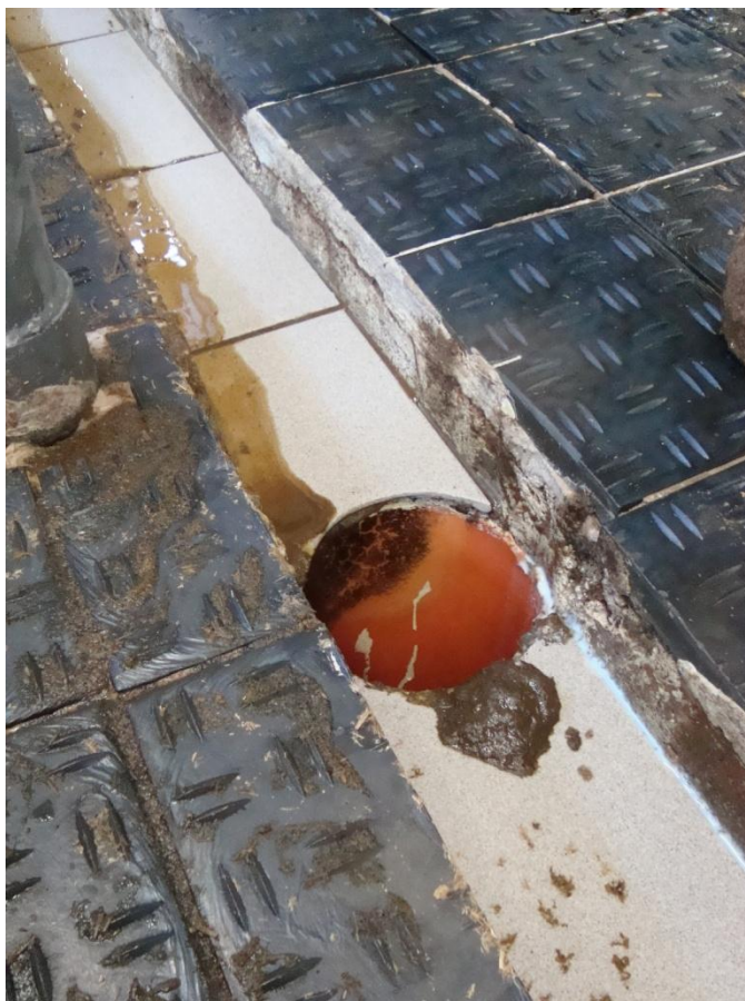
Obr. 1.17 – Odpadní svody v podlaze na dojárně
