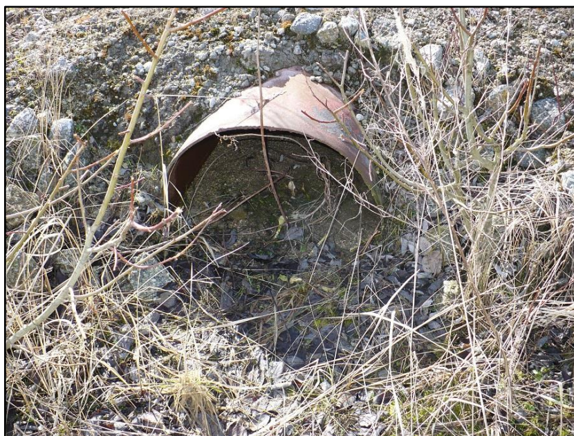
Obr. 25: Ucpaný propustek Zdroj: Foto Jan Zábojník
