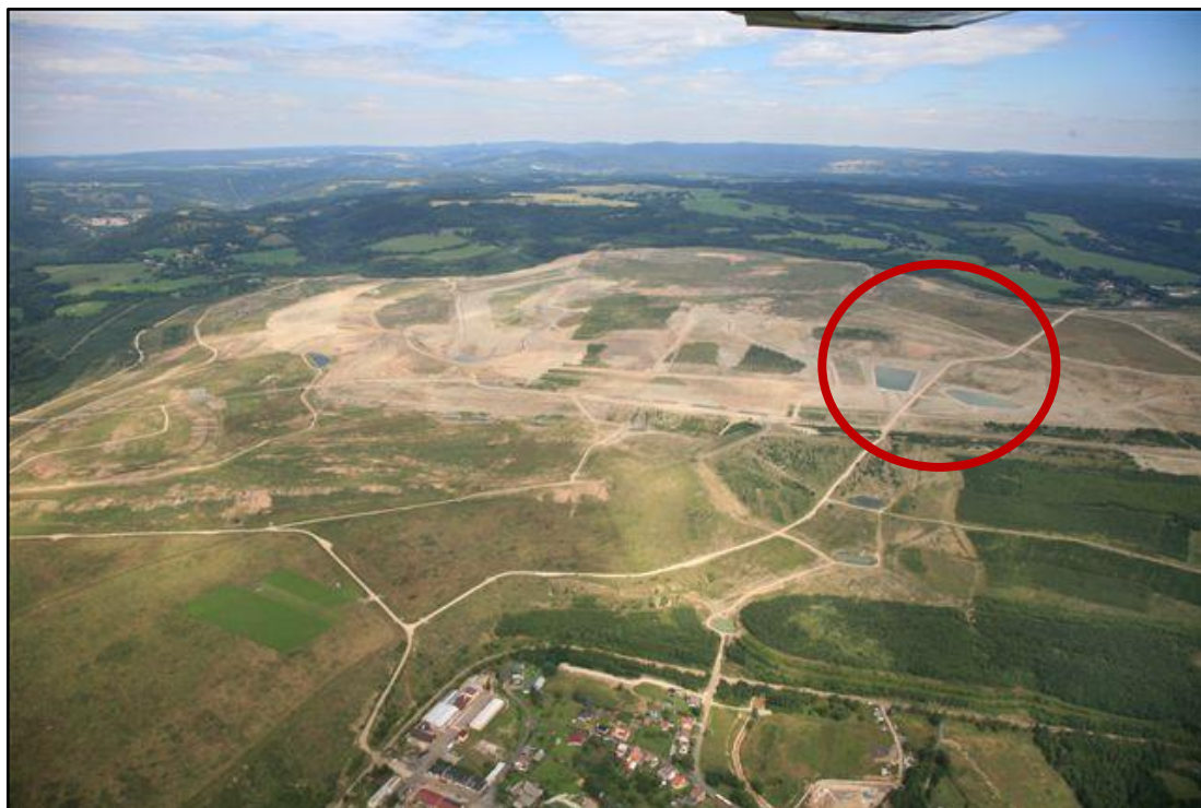
Obr. 16: Retenční nádrže N1a N2
