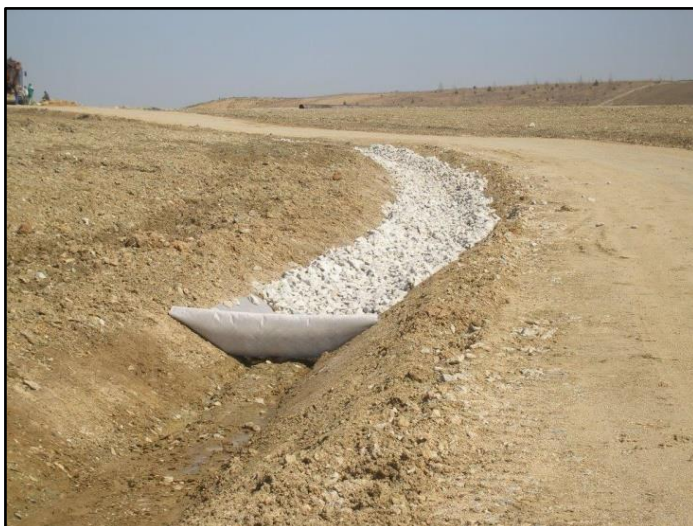
Obr. 17: Lichoběžníkový příkop Zdroj: SU a.s.
