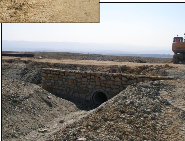
Obr. 18: Trubní propustek Zdroj: SU a.s.
