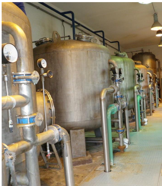
Obr. 3.5 Tlakové filtry [27]
