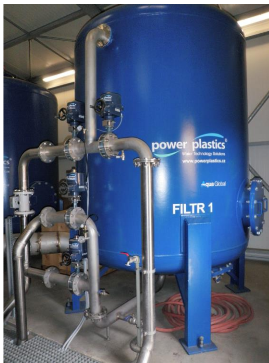
Obr. 4.13 Tlakový filtr s aktivním granulovaným uhlím
