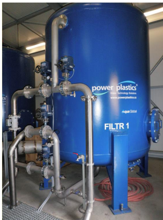
Obr. 4.13 Tlakový filtr s aktivním granulovaným uhlím
