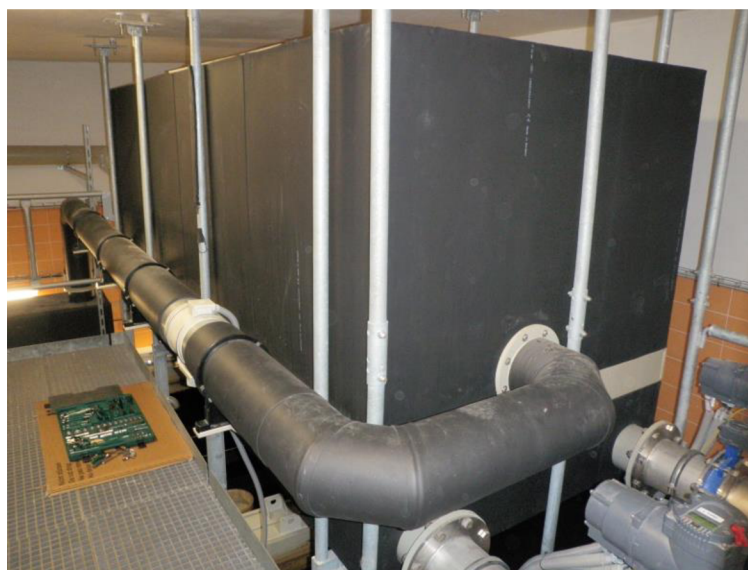
Obr. 4.9 Provzdušňovací reaktor
