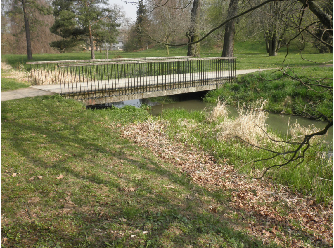
Obr. 10: Most v zámeckém parku ř. km 10,243, pohled proti proudu [12].
