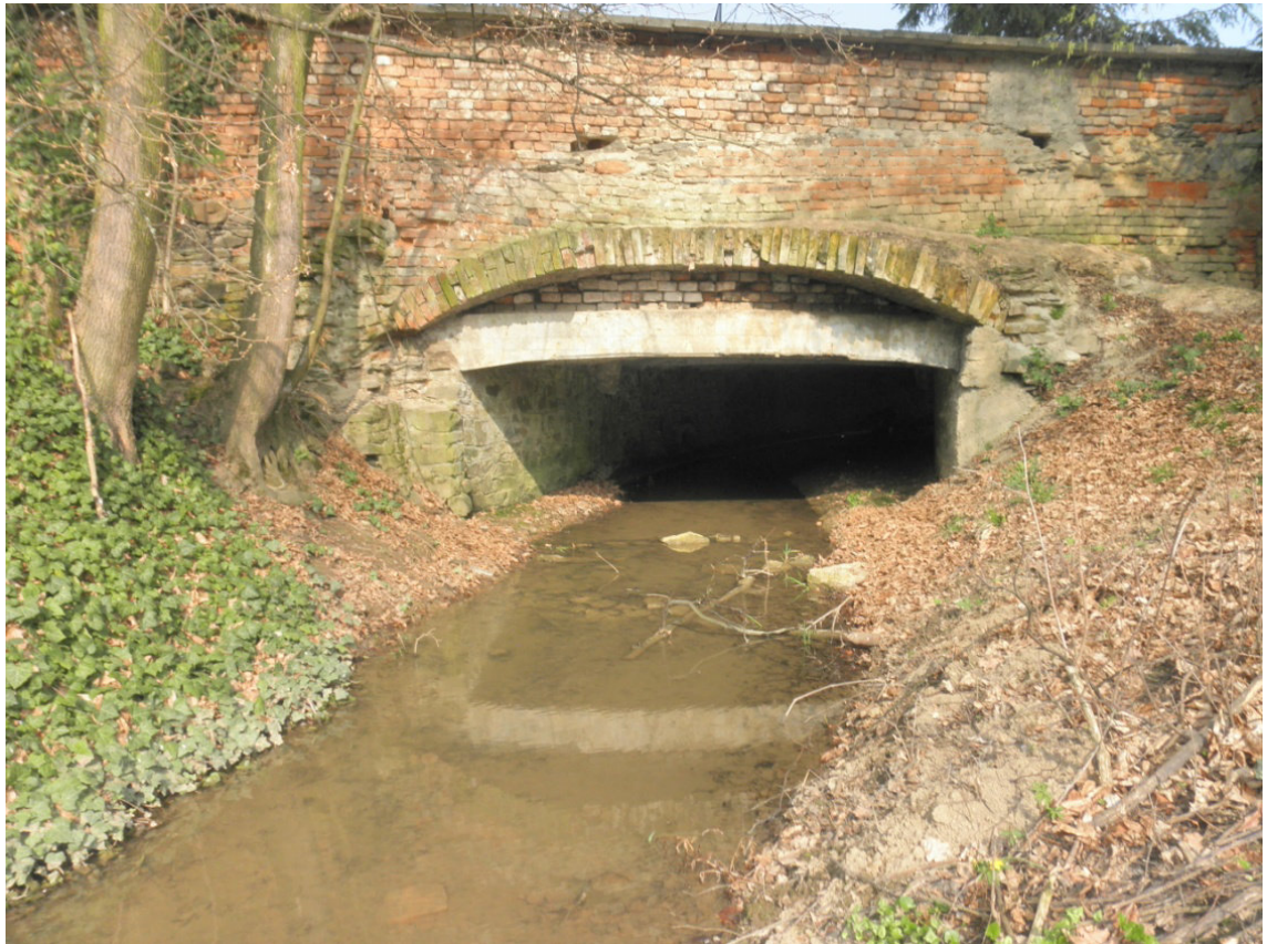
Obr. 11: Silniční most ř. km 10,415, pohled proti proudu [12].
