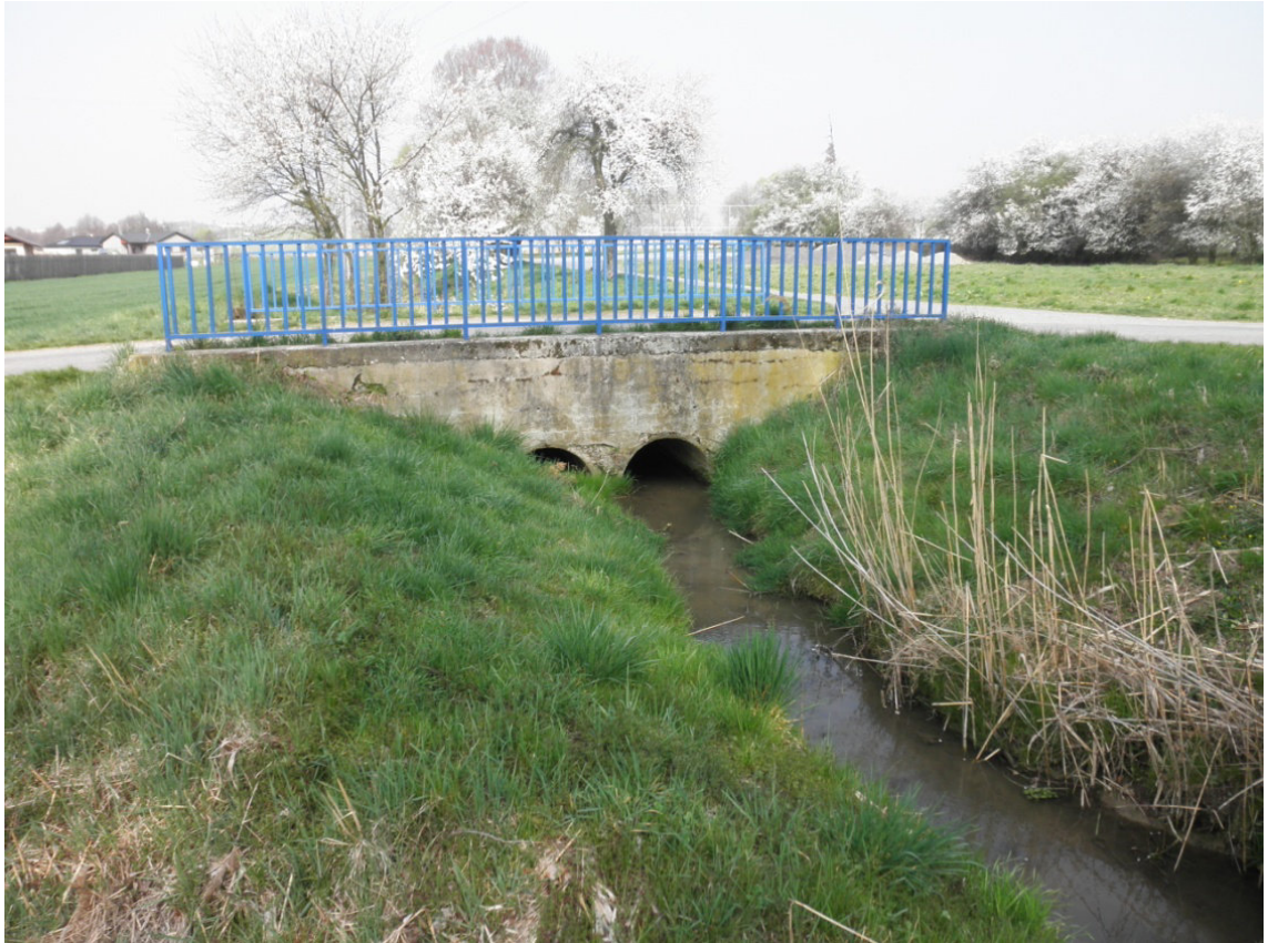
Obr. 17: Hospodářský most, ř. km 11,047, pohled proti proudu [12].
