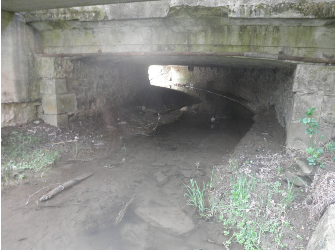
Obr. 12: Lávka v ř. km 10,426, pohled po vodě, s průhledem pod silniční most [12].
