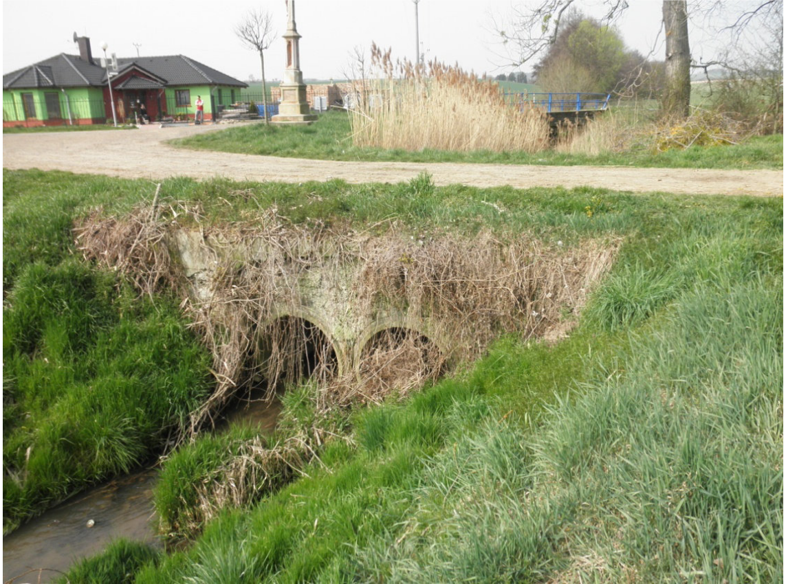
Obr. 18: Hospodářský most, ř. km 11,355, pohled po proudu [12].
