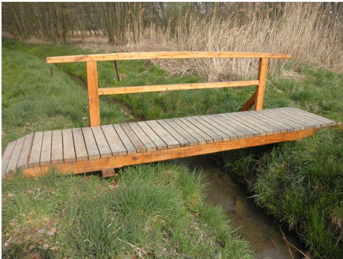
Obr. 16: Nová lávka v ř. km 10,673, pohled proti proudu [12].
