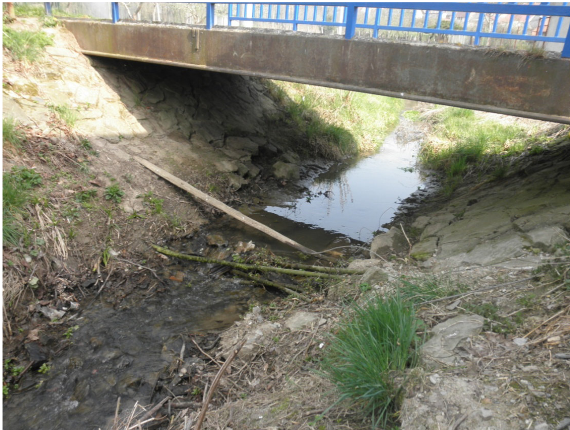
Obr. 15: Mostek v ř. km 10,615, pohled proti proudu [12].
