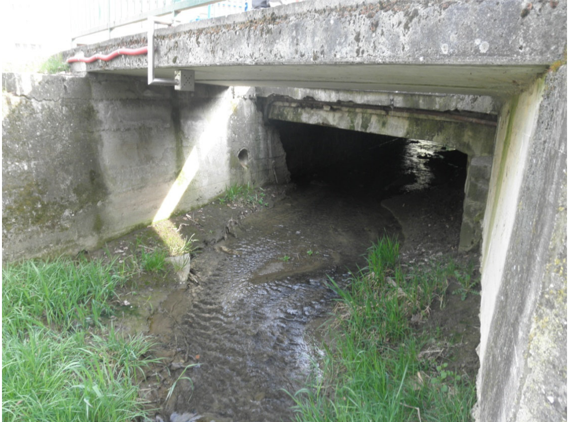
Obr. 13: Lávka v ř. km 10,497, pohled proti proudu [12].
