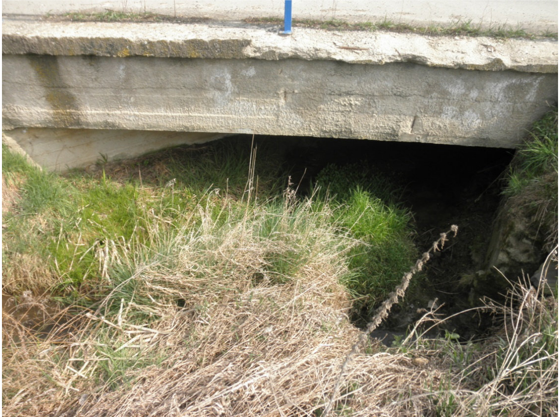
Obr. 19: Silniční most, ř. km 11,371, pohled proti proudu [12].
